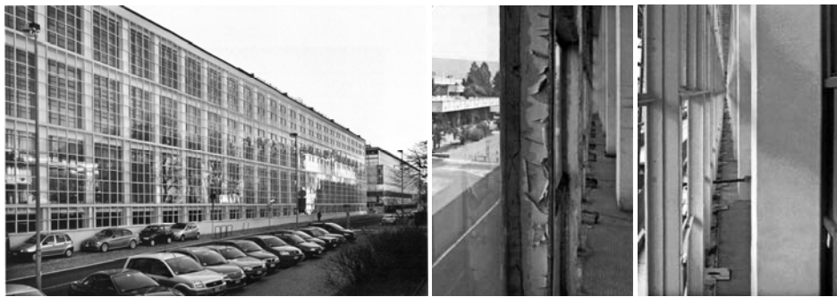
L'officina ICO Centrale di Ivrea. A partire da sinistra: prospetto lungo via Jervis, la grande doppia parete vetrata prima e dopo il restauro.
