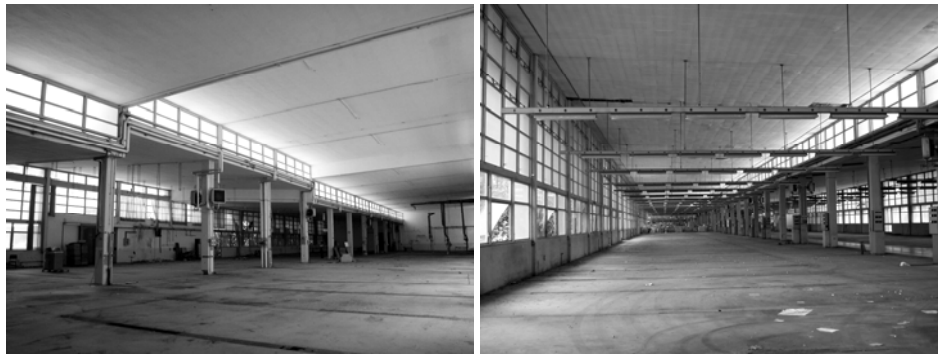
Vedute interne dei corpi officina
