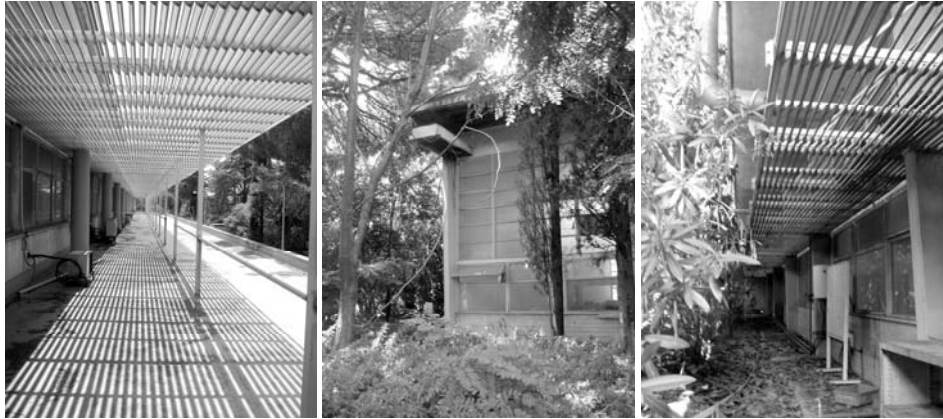
Elementi di protezione: frangisole, pensiline, uso della flora
