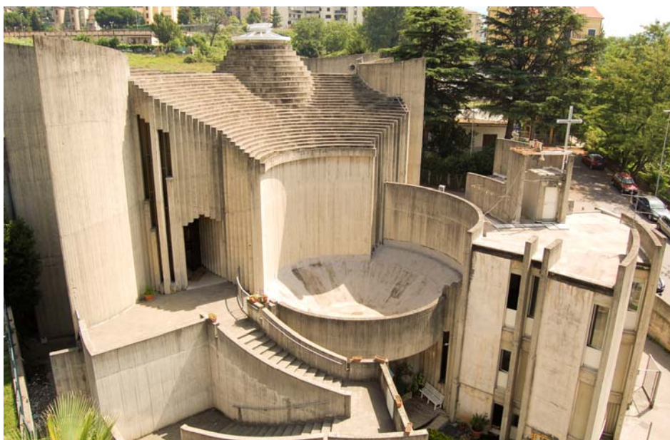
Veduta dall'alto del prospetto sud est
