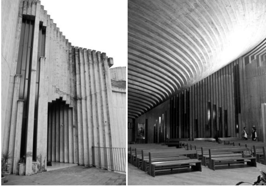
Particolari intersezioni tra elementi realizzati tramite l'utilizzo di riseghe, in corrispondenza dell'ingresso principale e all'interno della chiesa.
