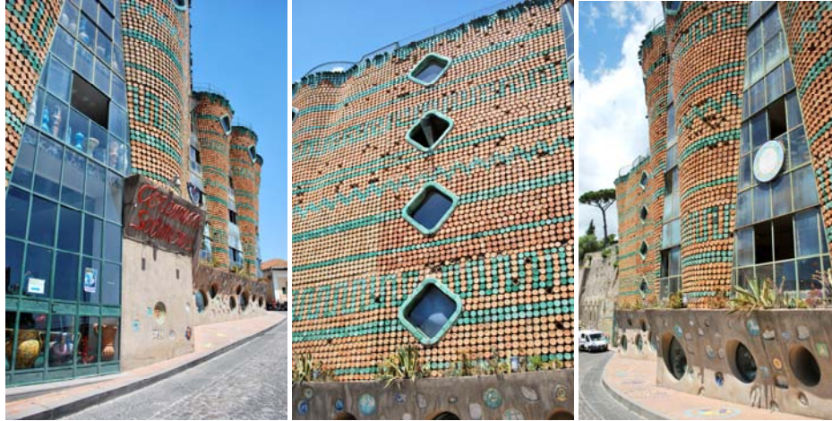
Particolari del prospetto a mare, caratterizzato dal particolare rivestimento fittile.
