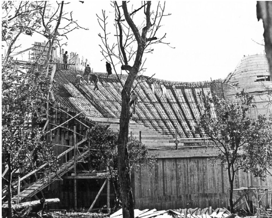
Immagine del cantiere della chiesa
