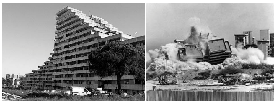
Le «Vele» di Scampia, Napoli, progettate da Franz Di Salvo tra il 1968 e il 1974. A destra immagine della demolizione di una parte avvenuta nel 1997.
