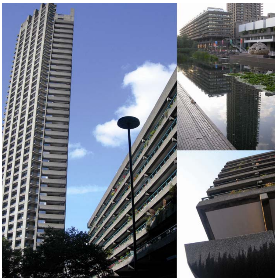
Fig. 6. Barbican Estate . Sulla sinistra una delle tre torri del complesso residenziale, che ancora oggi sono tra gli edifici più alti d'Europa; 42 piani per 123 metri di altezza. In alto a destra una veduta di insieme di uno dei tanti spazi pubblici aperti. In basso a destra un particolare dei balconi in calcestruzzo armato. Le immagini sono state scattate nell'agosto 2009 durante un periodo di studio e di ricerca condotto presso il Greenwich City Council.
