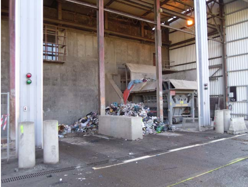
Figura 5.5 Fossa accumulo frazione secca del centro trattamento rifiuti Habay-la-Neuve (Belgio)
