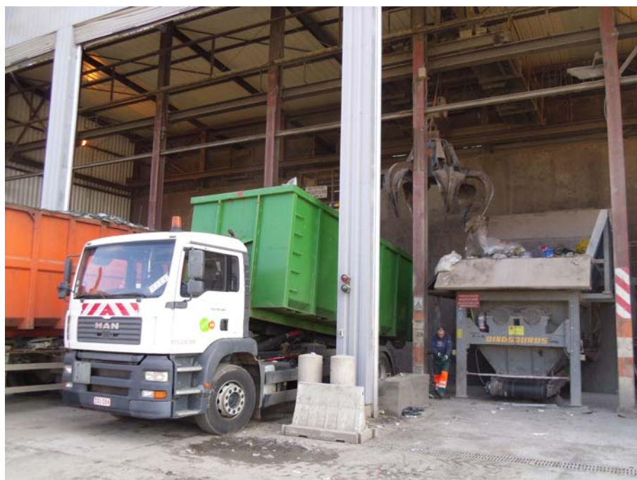
Figura 5.7 Conferimento frazione secca alla fossa di accumulo del centro trattamento rifiuti Habay-la-Neuve (Belgio)
