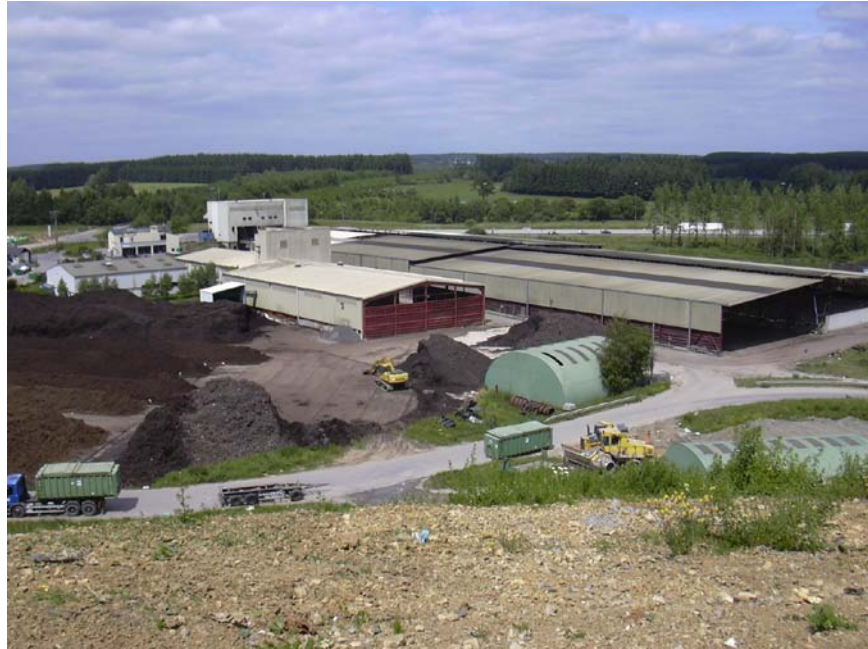
Figura 5.1 Centro trattamento rifiuti Habay-la-Neuve (Belgio)
