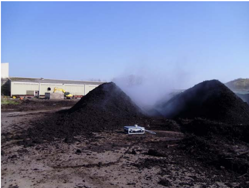
Figura 5.6 Zona trattamento materiale verde per compostaggio del centro trattamento rifiuti Habay-la-Neuve (Belgio)
