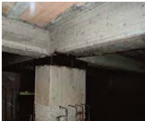
Fig. 3.9.4: Interventi di rinforzo delle travi con placcaggi metallici
