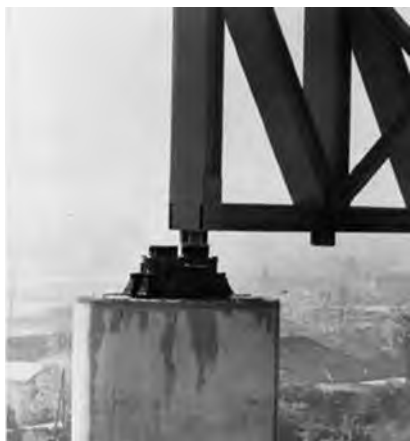
Connessione della trave principale sui vincoli
