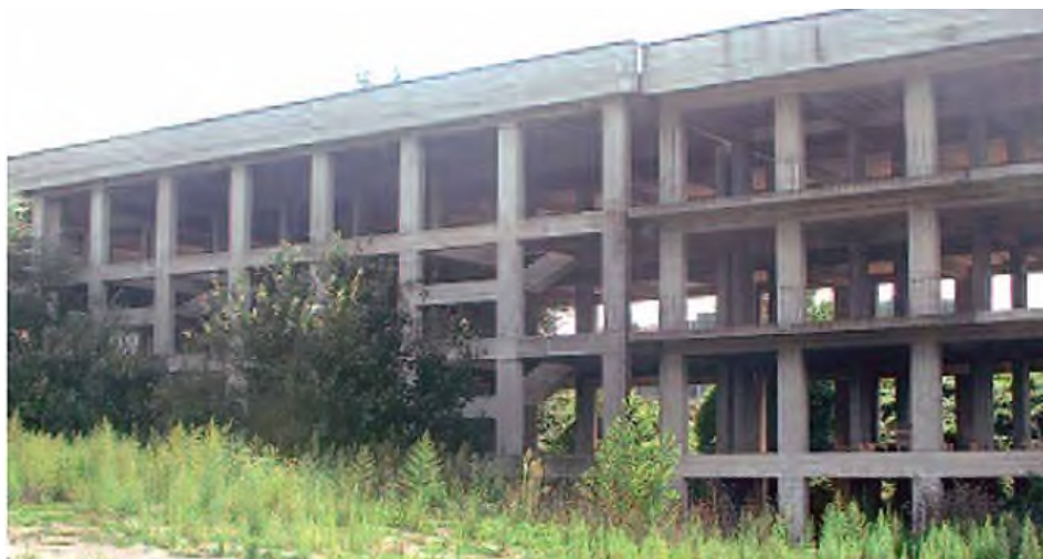
Fig. 3.9.1: Vista di una struttura della città ospedaliera di Avellino in fase precedente all'intervento di isolamento sismico
