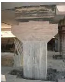
Fase 5: Ringrosso dei pilastri centrali
