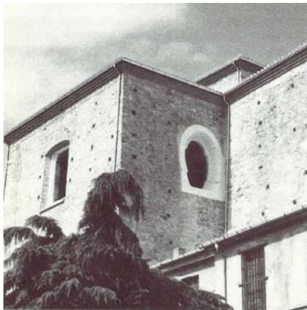
Fig. 3.4.1: Vista della chiesa di San Battista a Carife (AV)
