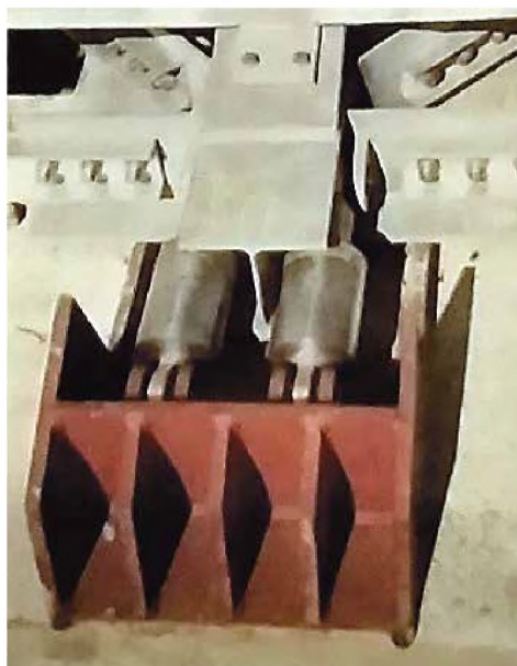
Particolari della messa in opera dei dispositivi oleodinamici a vincolo provvisorio
