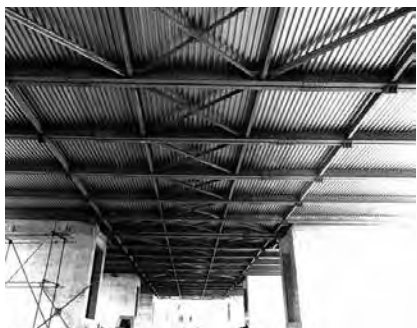
Impalcati di piano visti dal basso
