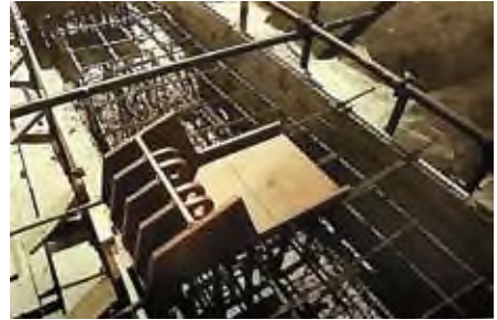
Particolare del posizionamento delle piastre per vincoli fissi e scorrevoli
