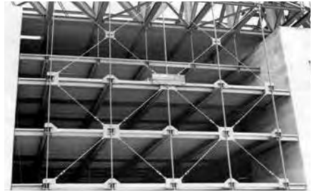
Controventi di facciata
