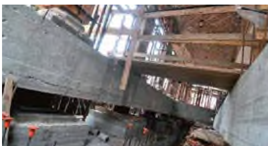
Foto 4: Vista del baggiolo della sottostruttura, del sistema di isolamento, del cordolo di base e della sovrastruttura
