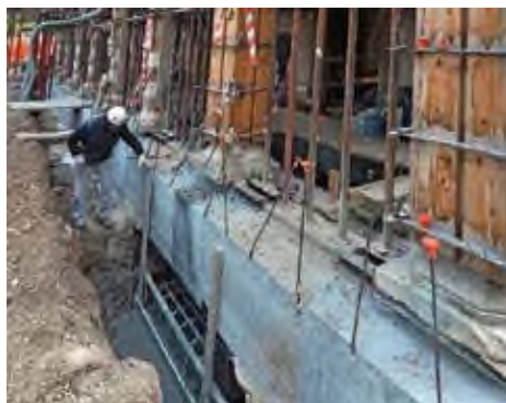
Foto 2: Fase di scavo e realizzazione dei baggioli di appoggio
