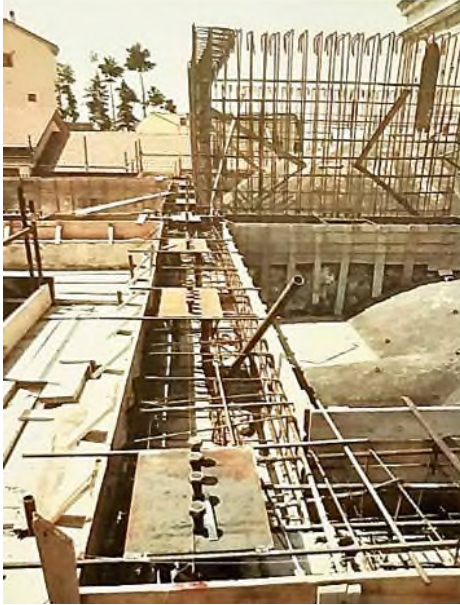
Particolare del posizionamento delle piastre per vincoli fissi e scorrevoli
