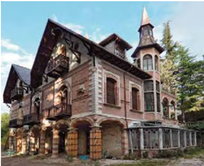
Fig. 3.11.1: Vista di Villa La Silvestrella precedente all'intervento di adeguamento
