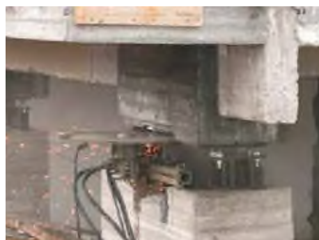
Fase 2: Taglio dei pilastri
