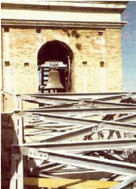
Struttura metallica di copertura (grigliato, capriata)
