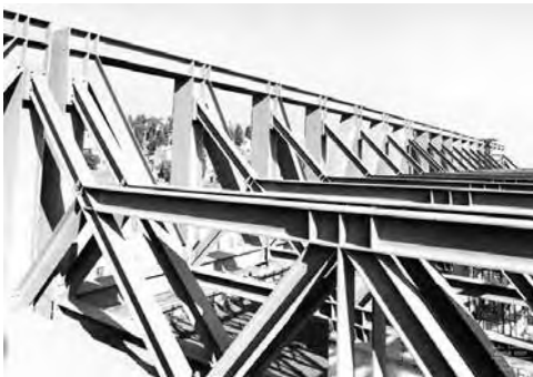
Dettaglio del collegamento tra le travi reticolari
