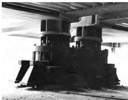
Vista del doppio dispositivo di vincolo tra due maglie strutturali adiacenti
