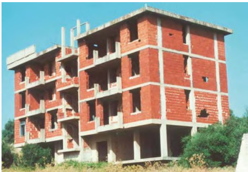
Fig. 3.8.1: Vista dell'edificio IACP
