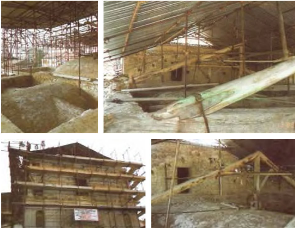
Fig. 3.4.4: Immagini della chiesa prima dell'intervento di adeguamento
