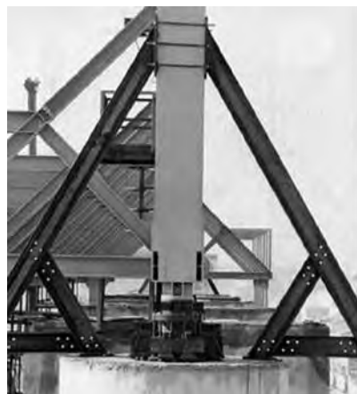
Connessione della trave principale sui vincoli
