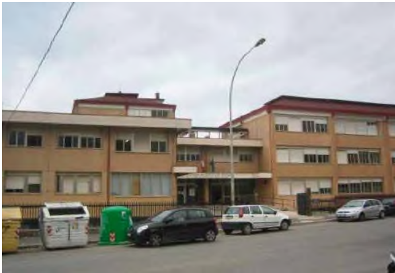
Fig. 3.10.1: Vista della struttura precedente all'intervento di adeguamento
