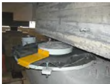
Fase 6: Inserimento degli isolatori a scorrimento
