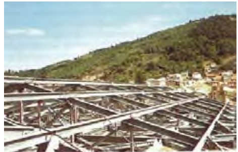
Particolare del posizionamento delle piastre per vincoli fissi e scorrevoli
