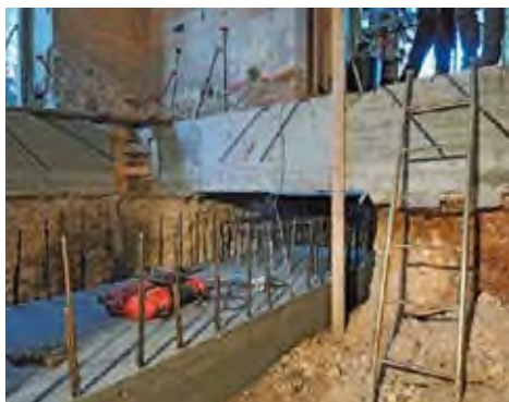
Foto 1: Vista della sottofondazione dell'edificio in muratura
