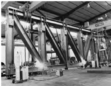
Fabbricazione della trave principale in officina
