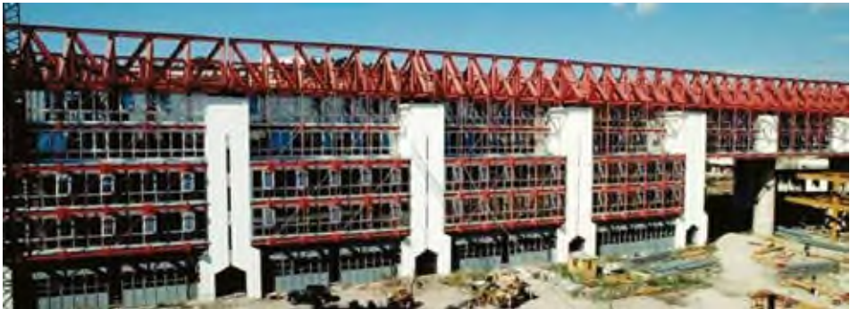
Fig. 3.1.1: Vista dell'edificio "A" in costruzione
