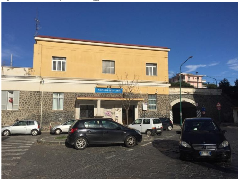
Figura 38 - Facciata del fabbricato viaggiatori
