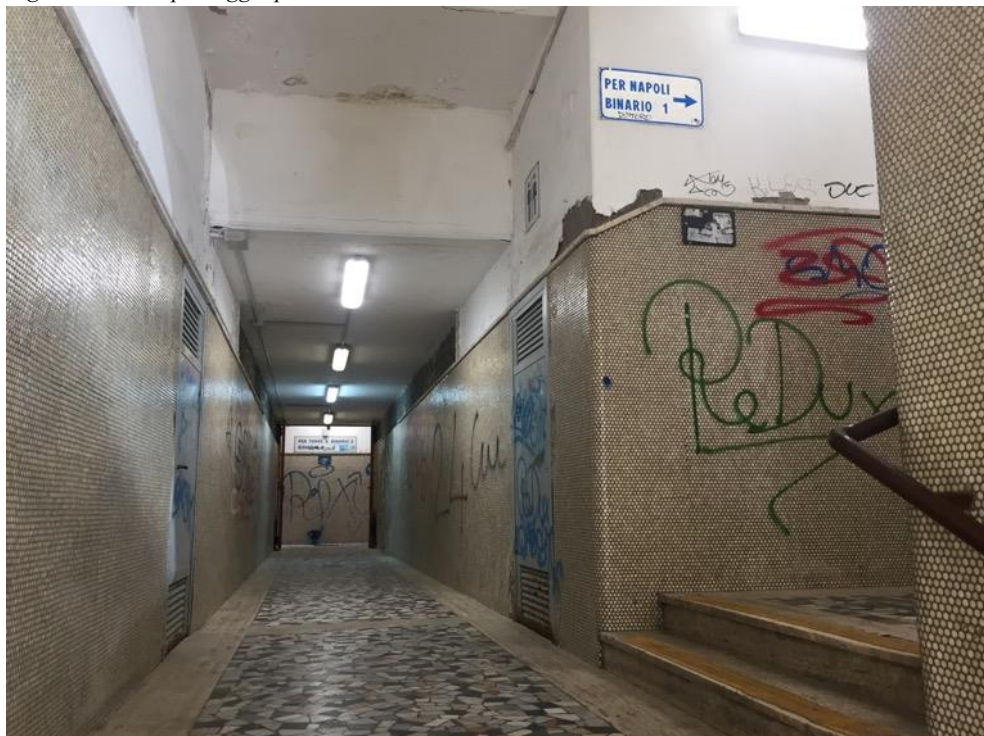
Figura 40 - Sottopassaggio per l'accesso ai wc ed ai binari
