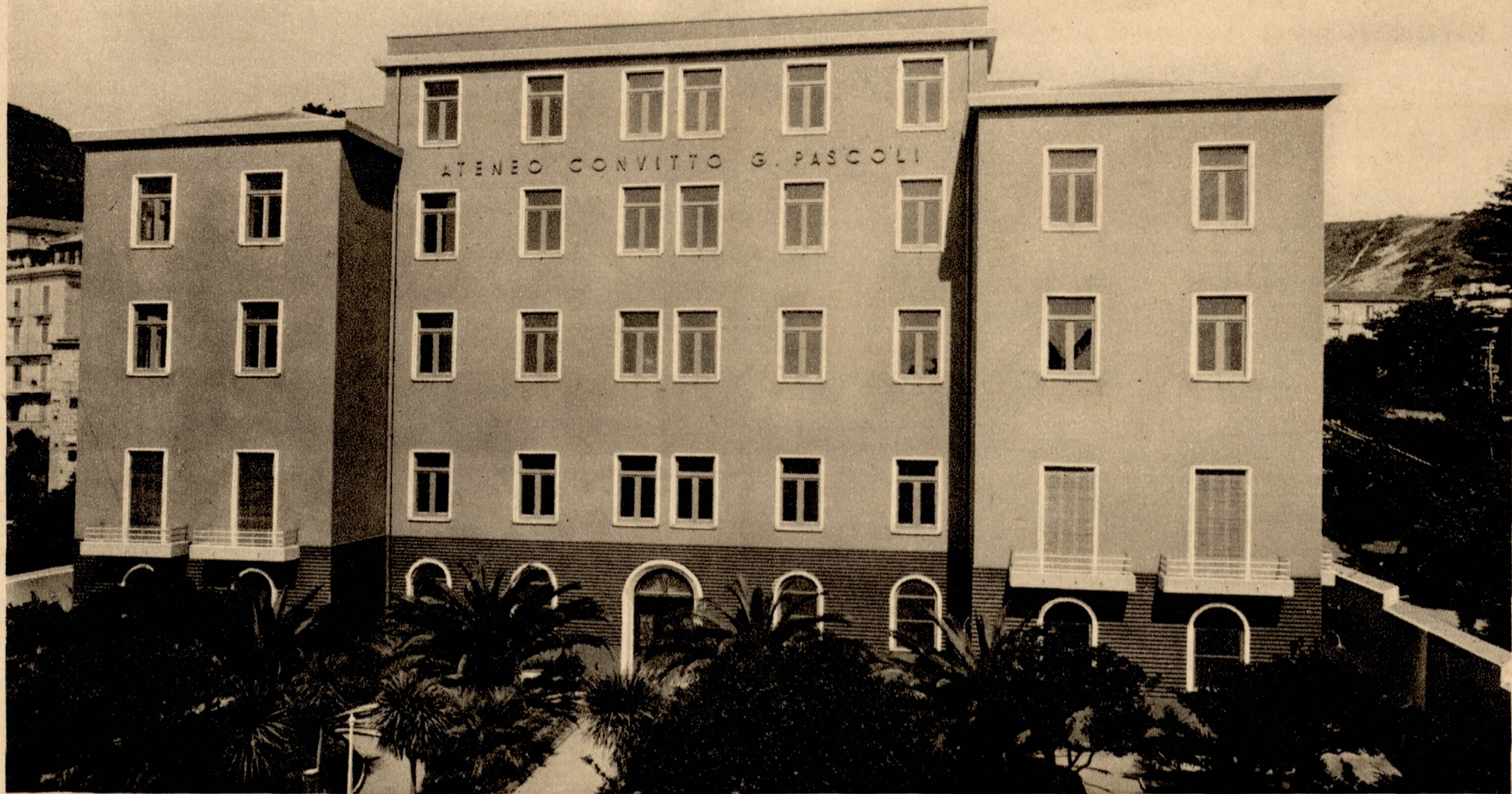
Sede del Convitto (Lato sud)
