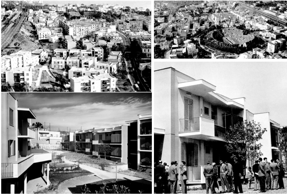
Fig. 5. 2: Quartiere INA-Olivetti, Pozzuoli (NA). Old aerial photos and inauguration in 1956. (From the book “Luigi Cosenza oggi, 1905-2005” A. Buccaro, G. Mainini, CLEAN, Napoli 2006.
