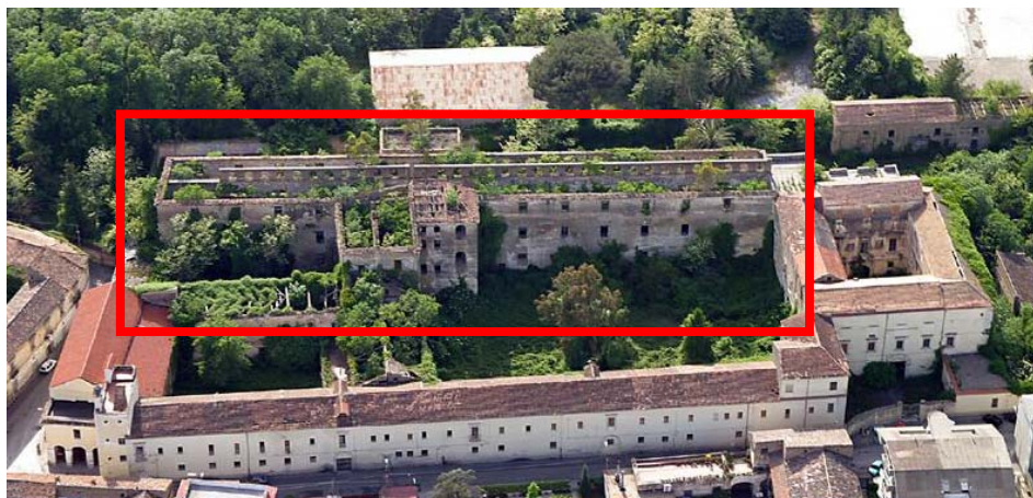
Fig. 51 Il Padiglione Militare prima degli ultimi interventi parziali di recupero
