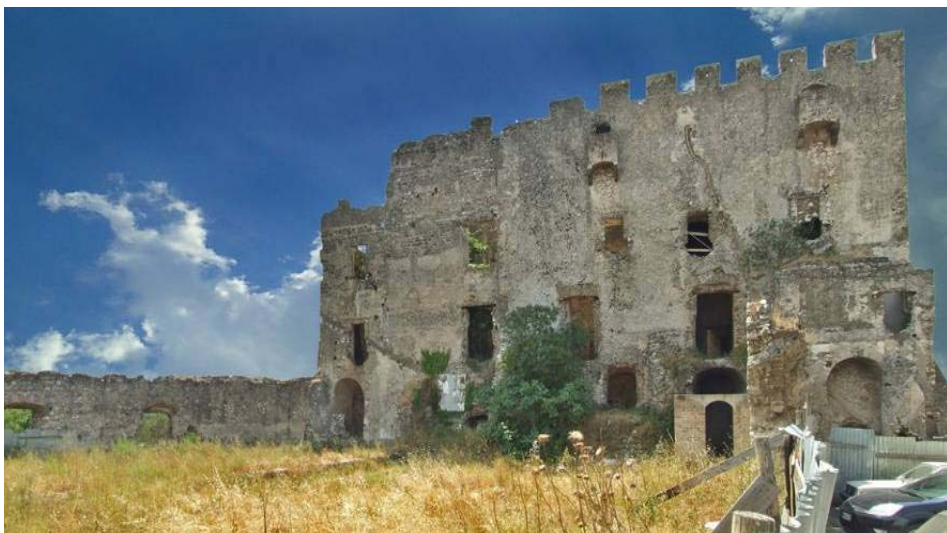
Fig. 79 Foto del prospetto prospiciente la corte
