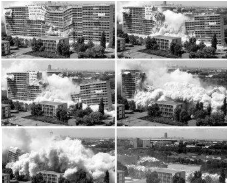
Figura 1.16 Sequenza di immagini su una fase della demolizione della Courneuve nel 2001. Fonte: frame dal video dello studio freaks free architects.
