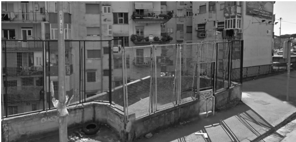
Figura 1.10 L'isola di suolo: il Rione Lauro a Napoli è caratterizzato da un salto di quota di una decina di metri che corre lungo tutto il versante nord dell'insediamento sviluppato per terrazzamenti privi di permeabilità ai bordi. Fonte: elaborazione personale.
