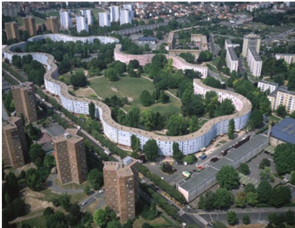
Figura 2.15 La relazione tra natura e costruito prima della riqualificazione: vista aerea della serpentina
