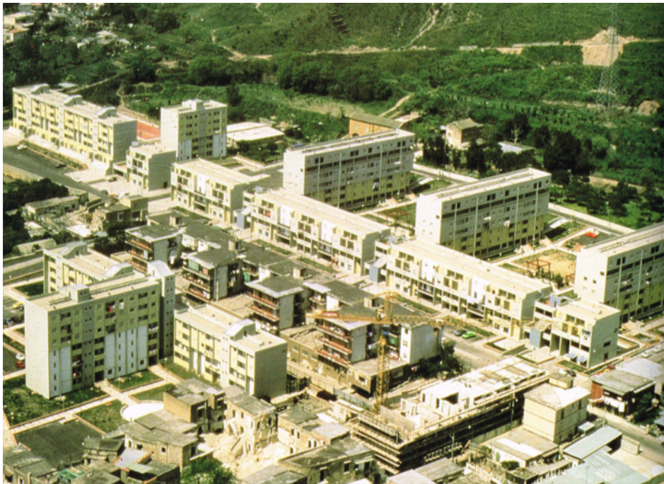
Figura 3.15 L'insediamento in costruzione nel 1986. Fonte: Rivista "architetti napoletani 1970-2000".
