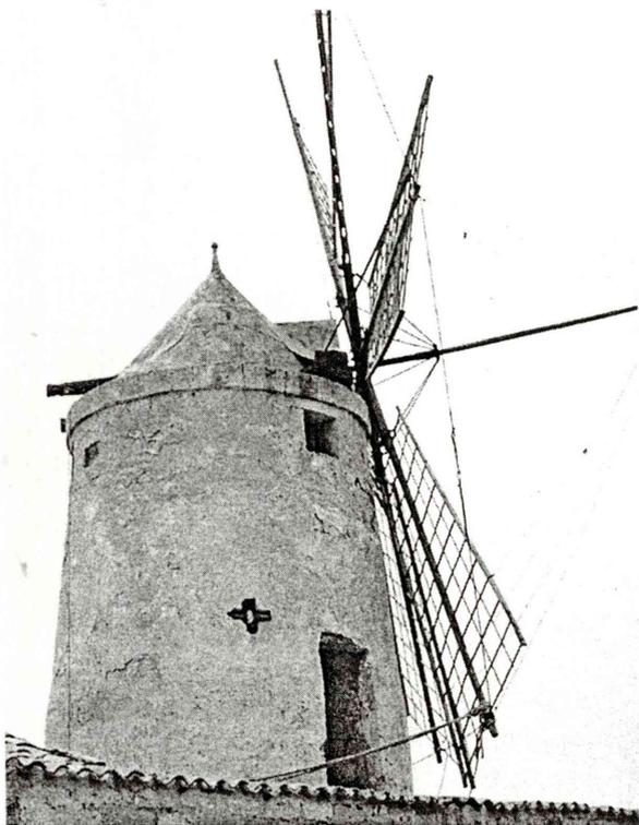
36. La torre fissa in pietra di forma tronco-conica con la cupola superiore girevole: mulino a vento delle Saline Culcasi a Paceco
