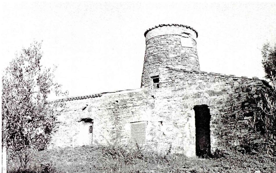
35. Veduta laterale del mulino: la parte ancora intatta dell'originaria copertura piana praticabile visibile al centro dell'edificio
