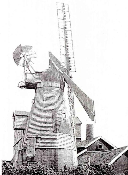
12. Mulino con sistema automatico di rotazione con la girandola a ventaglio
