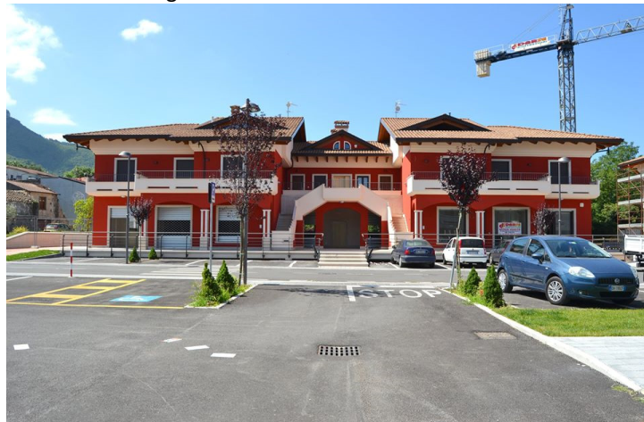
Fig. 20 Vista frontale del fabbricato ultimato
