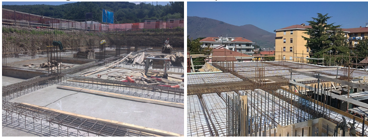
Fig. 19 Fasi costruttive del fabbricato
