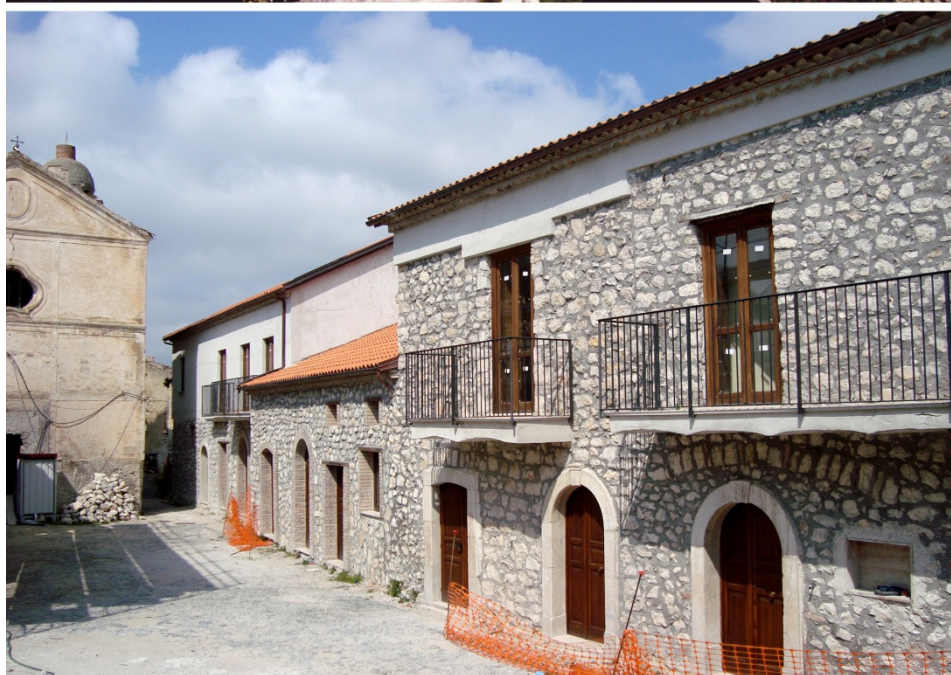
Particolare degli edifici su Piazza Castello a Romagnano al Monte in Campania – centro abbandonato dopo il sisma del 1980 – prima e dopo l'intervento di recupero.
