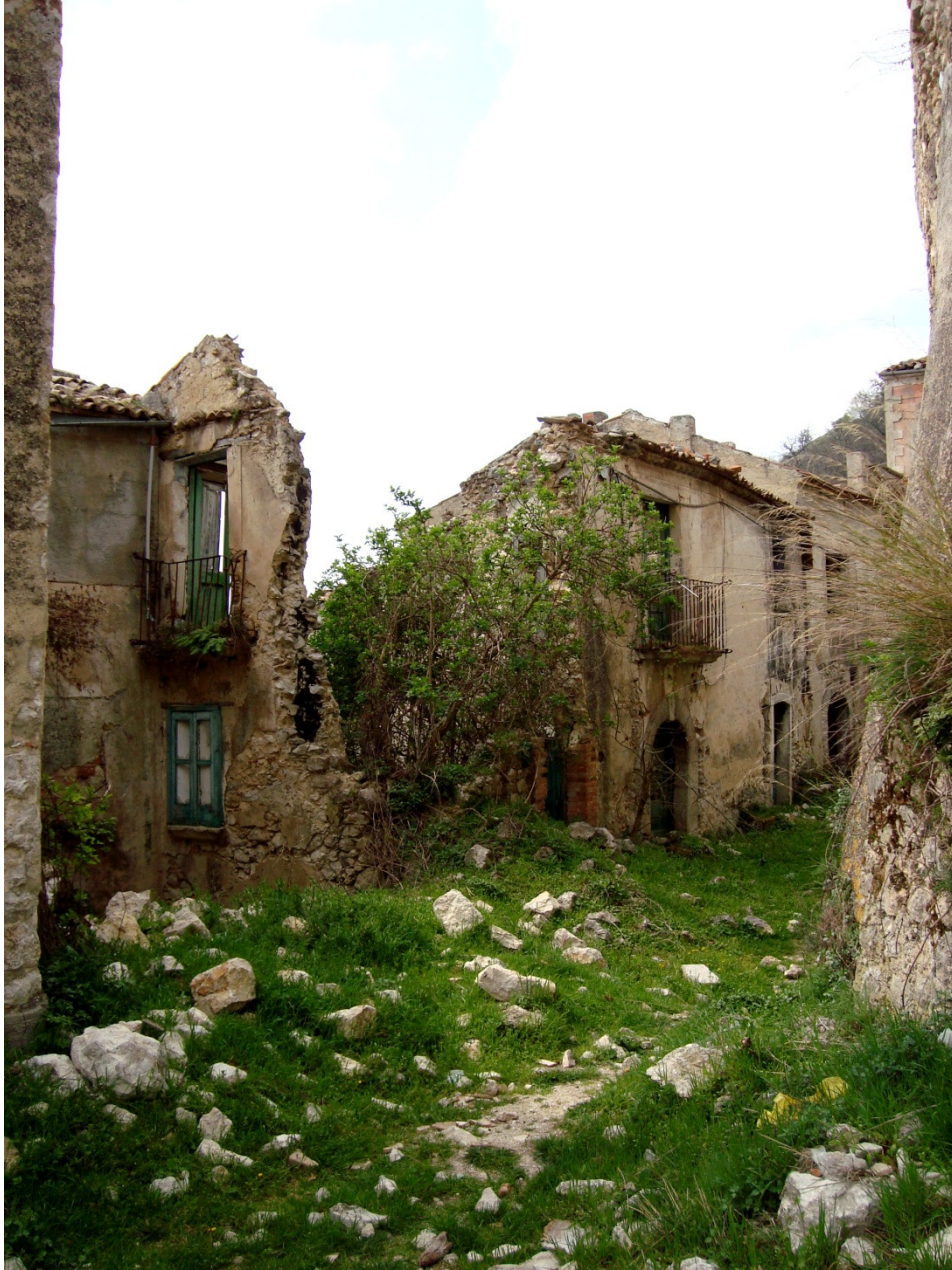
I ruderi del centro di Romagnano a Monte in Campania abbandonato dopo il terremoto del 23 novembre 1980.
