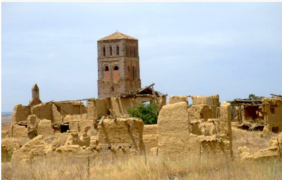
Le rovine dell'abitato di Honquilana (in alto) e di Villacreces (in basso) in provincia di Valladolid. Nei due centri tutta l'edilizia minore era costruita in adobe .
