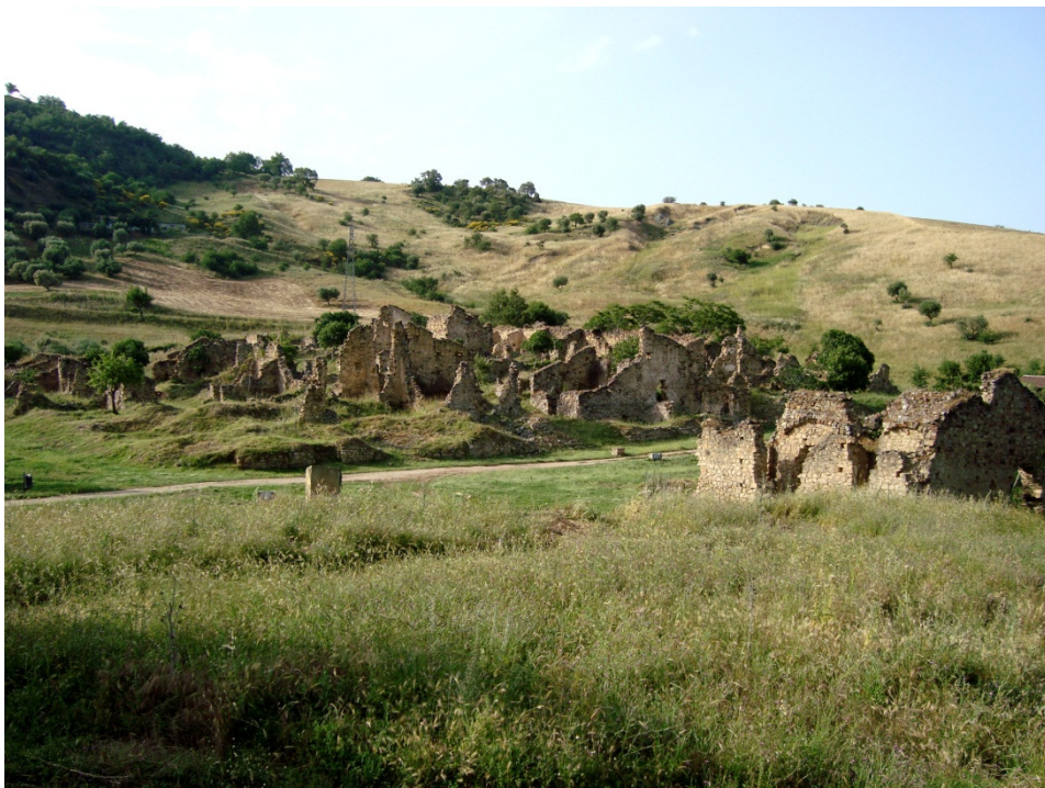
Rovine dell’abitato di Campomaggiore in Basilicata abbandonato a seguito di una frana nel 1885. L’abitato è trasferito quattro chilometri più a monte.
