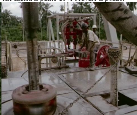
Operai nigeriani impegnati nel lavoro di trivellazione
