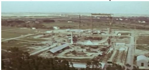
Panoramica del cantiere
