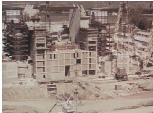
Panoramica del cantiere della centrale
