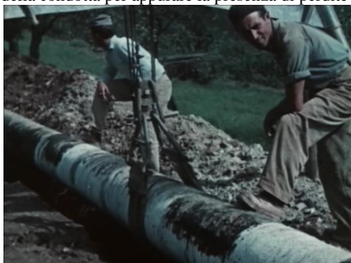
Posa del metanodotto nella trincea
