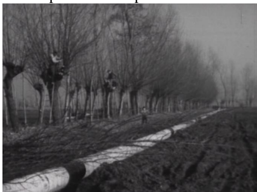
Posa in opera del metanodotto ( Le ricerche del metano... )
