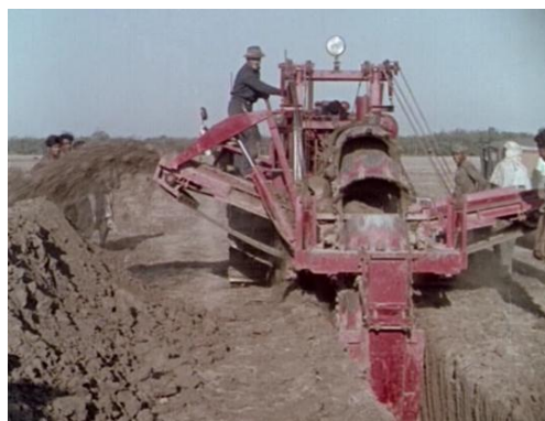
Lo scavo della trincea del metanodotto indiano
