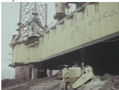
Le ruspe preparano il “cuscino” di sabbia sotto la piattaforma
