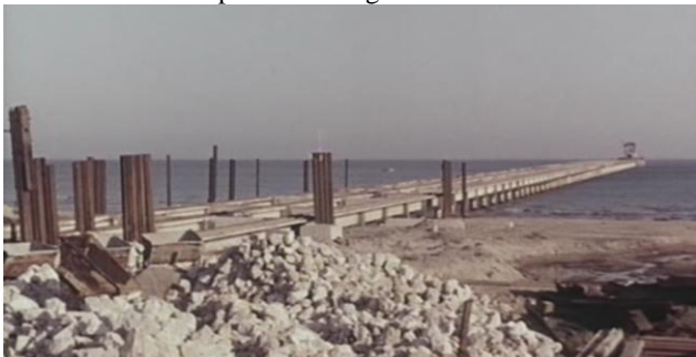
Il cantiere per le opere idrauliche
