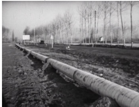
Un settore completi in attesa di essere interrato
