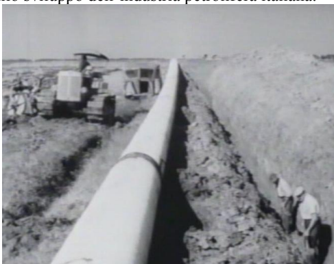
Lavori di posa dei metanodotti nella val Padana
