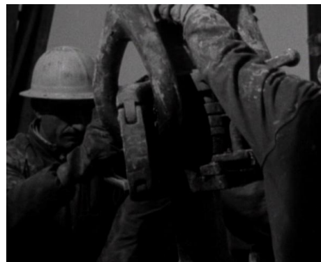
Operai addetti al montaggio delle aste
