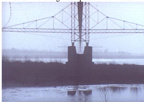
Ponte di metanodotto sopra un fiume
