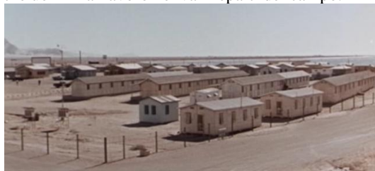
Case prefabbricate del villaggio operaio egiziano
