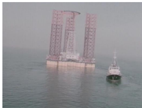
La piattaforma offshore costruita dal Nuovo Pignone
