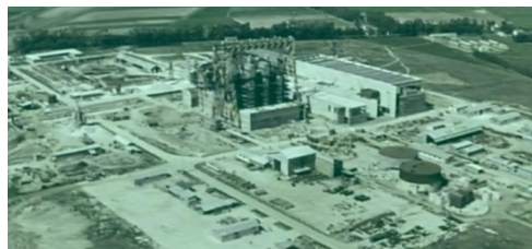
Il cantiere nell'estate del 1961
