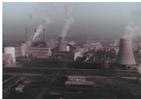
Panoramica dello stabilimento terminato
