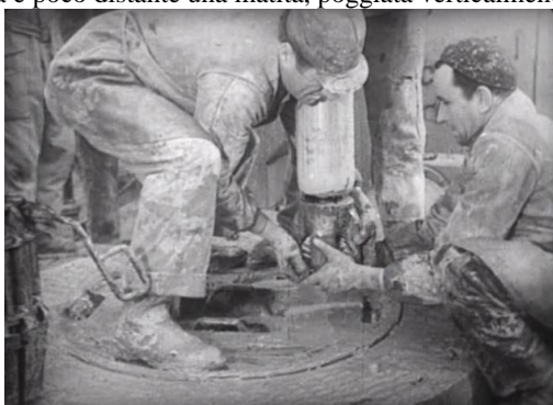
Montaggio della punta del trapano perforatore
