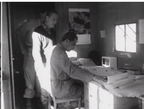
Tecnici impegnati nel laboratorio da campo
