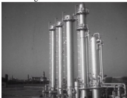
Gli impianti di Cortemaggiore ( Le vie del metano )
