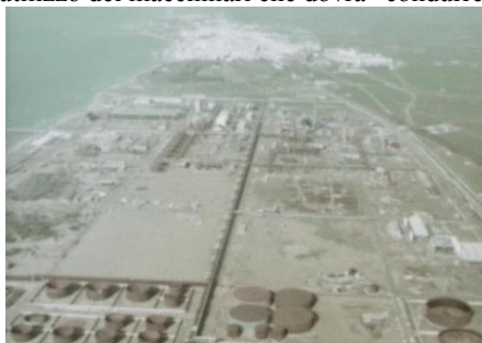
Veduta aerea del complesso industriale (sullo sfondo Gela)
