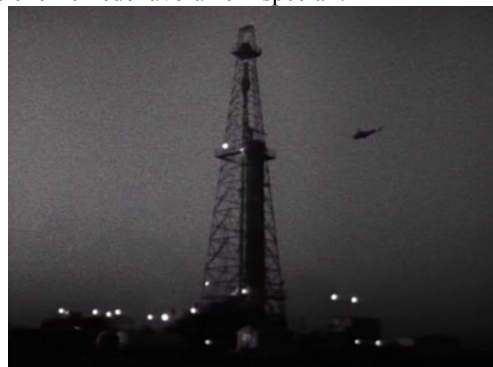
Il pozzo di notte mentre i lavori continuano
