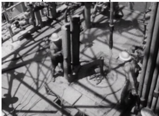
Il lavoro sullo “Scarabeo” ( Gela 1959: pozzi a mare )
