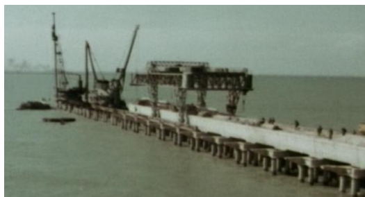
I lavori al pontile
