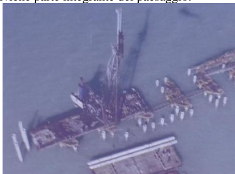
Panoramica aerea sul pontile in costruzione
