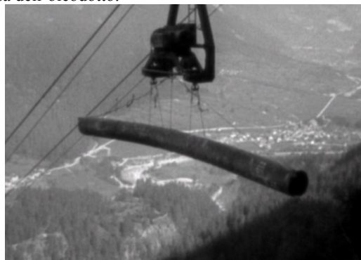
I tubi trasportati con la teleferica sulle Alpi
