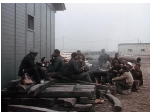
I primi operai che lavorano nel cantiere
