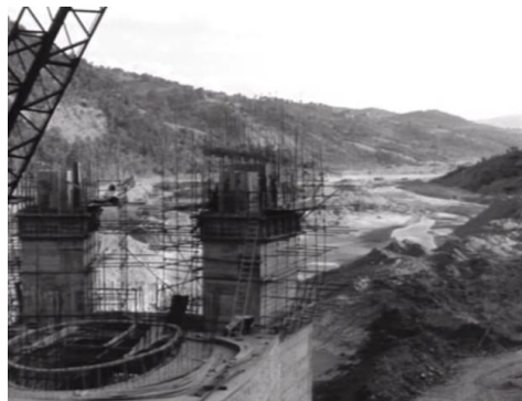
La costruzione dell'acquedotto del Frida
