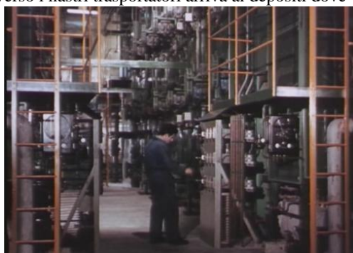
Momenti di lavoro all'interno dello stabilimento
