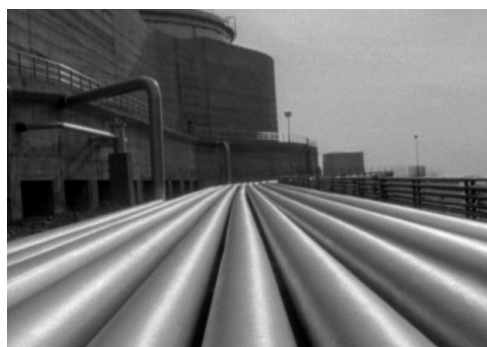
L'oleodotto nel tratto fuori terra
