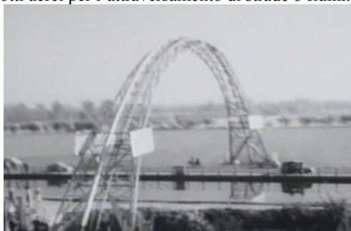
Metanodotto aereo per superare un fiume
