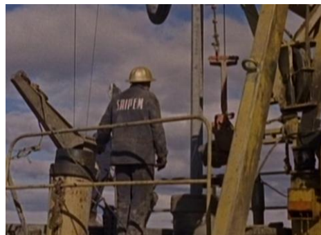
Operai della Saipem al lavoro sul pozzo di trivellazione
