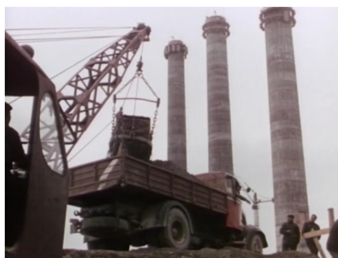
Il progresso dei lavori: le tre ciminiere sono pronte
