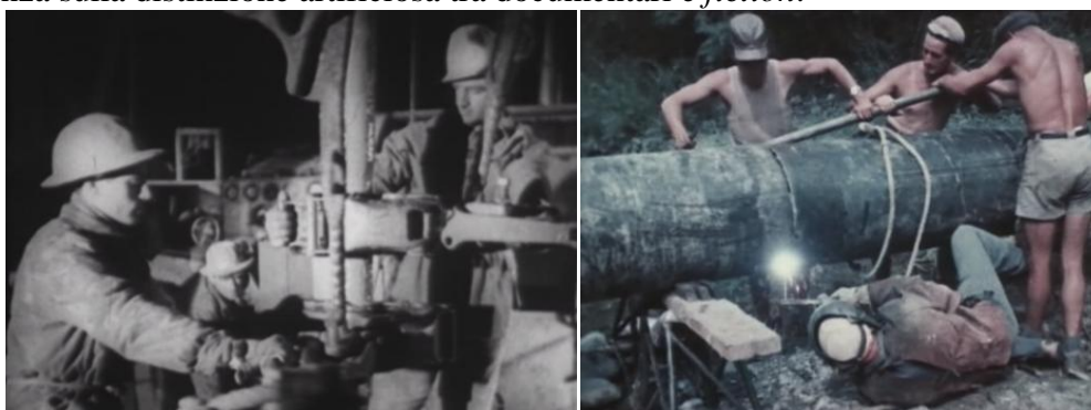
L'avvitamento delle aste ( Le vie del metano )
