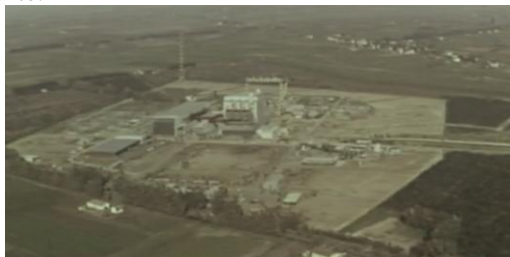
Panoramica della centrale nucleare alla fine dei lavori
