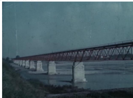
Metanodotto su fiume
