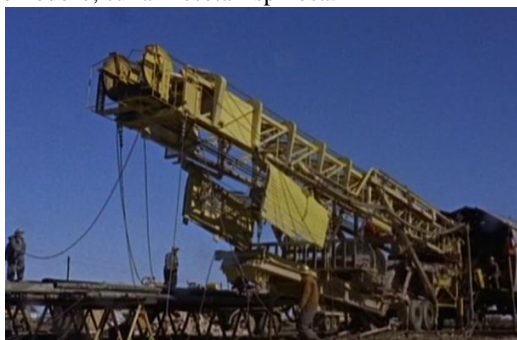
Lo smontaggio della torre di perforazione must
