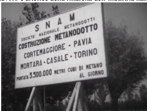
Il cartello dei lavori del metanodotto Cortemaggiore Torino
