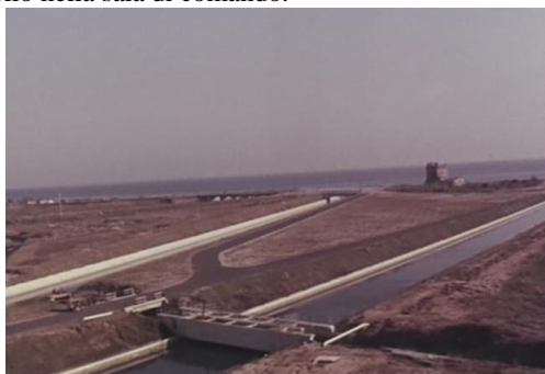
I canali a cielo aperto per l'acqua di mare
