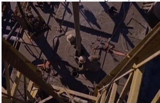
Riprese dall'alto della torre di perforazione
