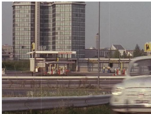
Il primo palazzo per uffici di Metanopoli
