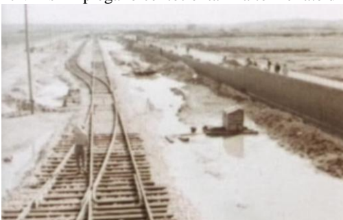
Lavori di costruzione dei binari nello stabilimento
