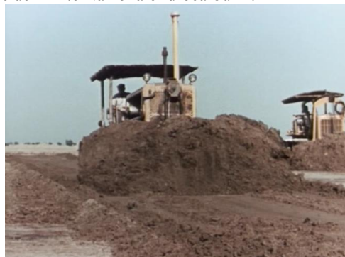
I lavori di sbancamento dell'area del cantiere
