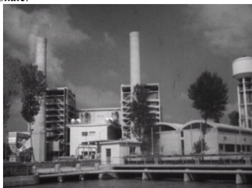
La centrale elettrica di Tavazzano (Lodi)
