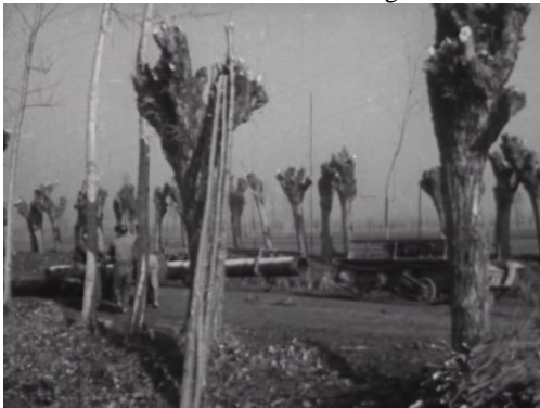
Lavori per la posa del metanodotto
