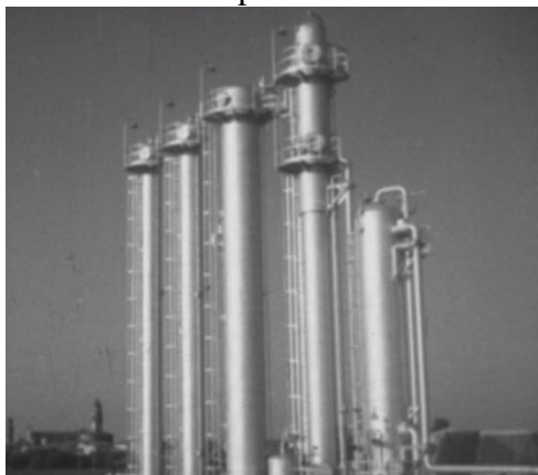
Le torri di degasolinaggio ( Le vie del metano )
