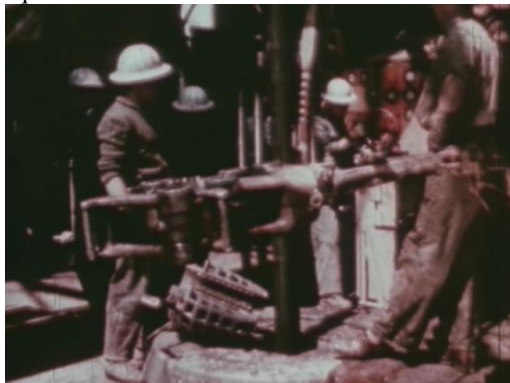
Il montaggio delle aste di perforazione
