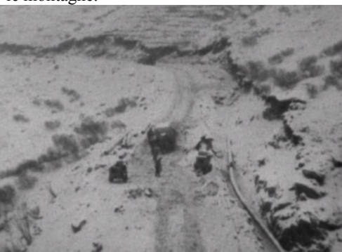
Il lavoro per la costruzione dell'oleodotto
