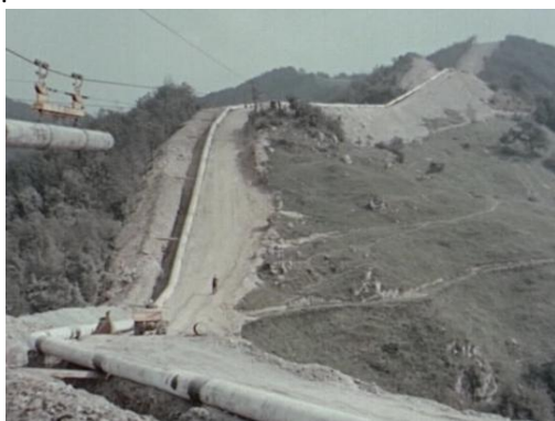
I lavori del metanodotto Genova-Ingolstadt
