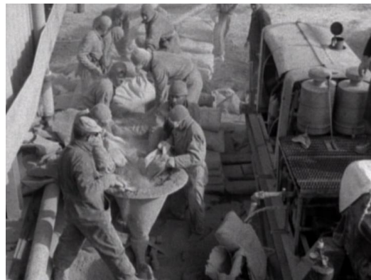
I lavori per cementare il pozzo durante la pausa invernale
