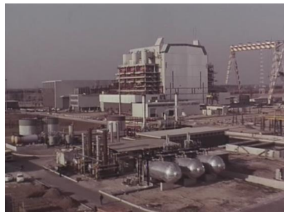
La centrale nucleare alla fine dei lavori
