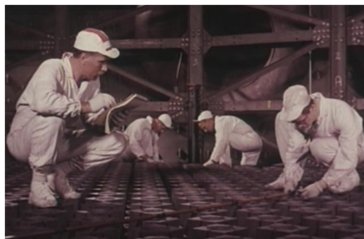
Il montaggio delle piastre di supporto nel reattore
