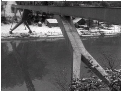
Il ponte dell'oleodotto sul fiume Reno
