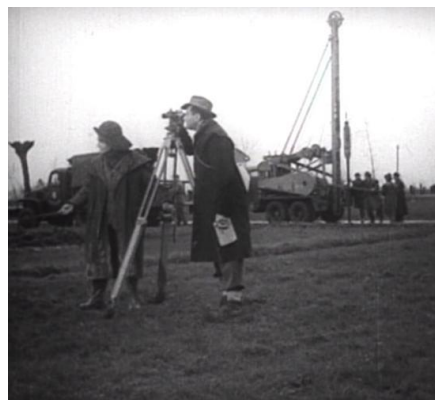
La preparazione del pozzetto sismico
