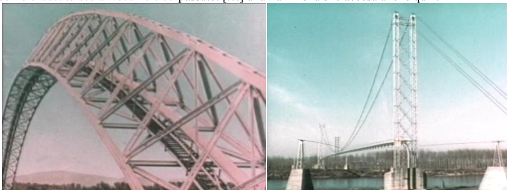
Due esempi di metanodotti aerei per l’attraversamento dei fiumi
