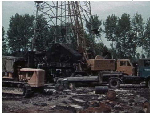
La costruzione della torre di perforazione
