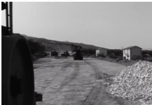
Lavori per la costruzione delle nuove strade
