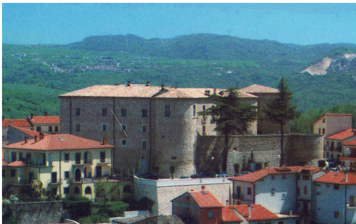
Figura 6 – Il castello di Torella dei Lombardi dopo il restauro conseguente al sisma del 1980.
