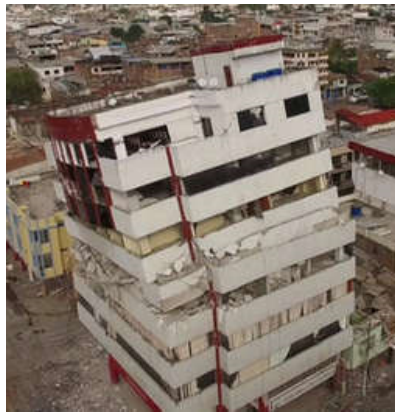
Figura 2.6: Meccanismo tipo 2 - Terremoto di Manabi, Ecuador 16 Aprile 2016
