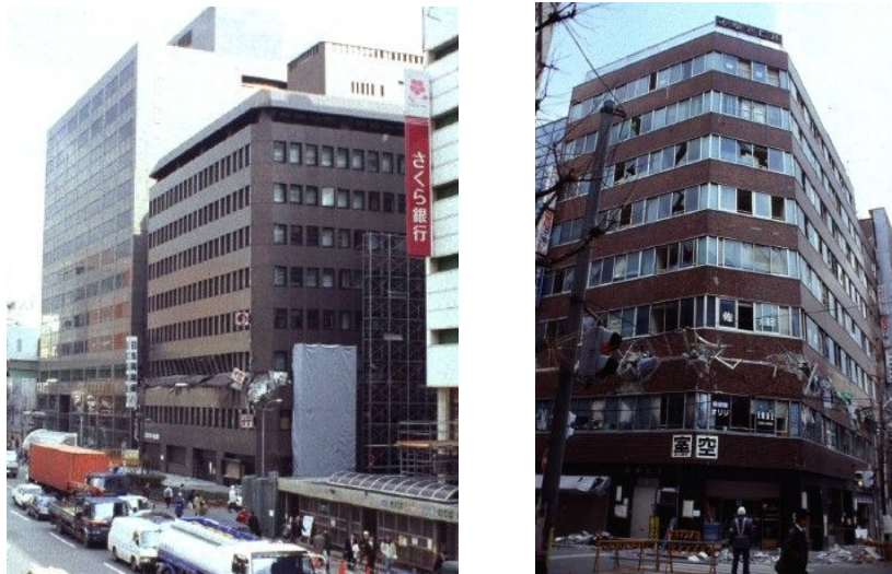
Figura 2.8: Meccanismo tipo 3 - Terremoto di Kobe, Giappone 17 Gennaio 1995
