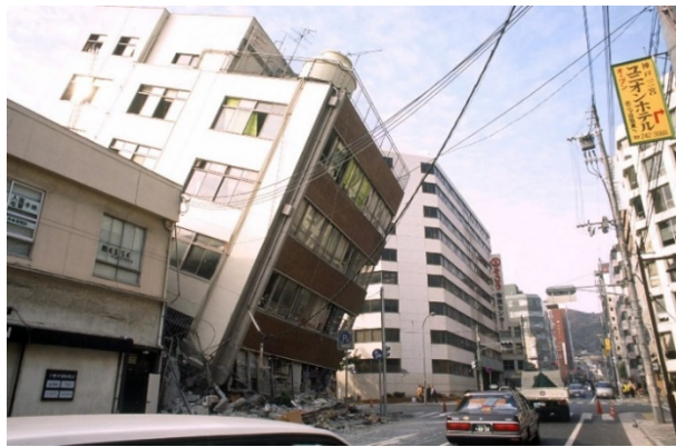
Figura 2.4: Meccanismo tipo 1 - Terremoto di Kobe, Giappone 17 Gennaio 1995
