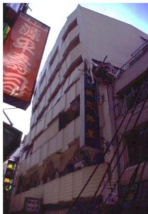
Figura 2.7: Meccanismo tipo 2 - Terremoto di Kobe, Giappone 17 Gennaio 1995
