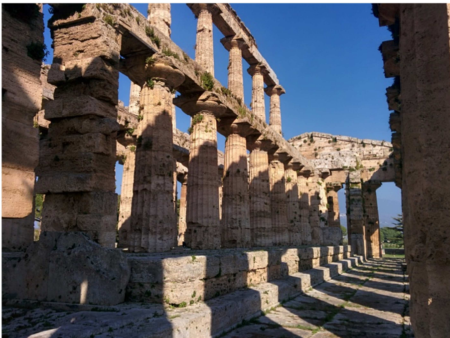
Figura 2.2.12: Doppio ordine di colonne del lato sud (Ispezione in sito).
