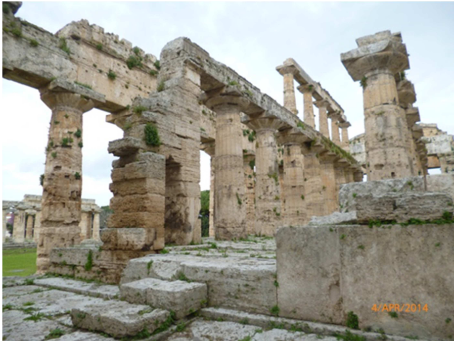
Figura 2.2.10: Ingresso della cella del tempio di Nettuno, vista nord-est (Ispezione in sito).
