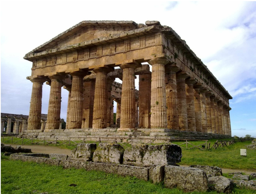
Figura 2.2.9: Vista nord-est del tempio di Nettuno (Ispezione in sito).
