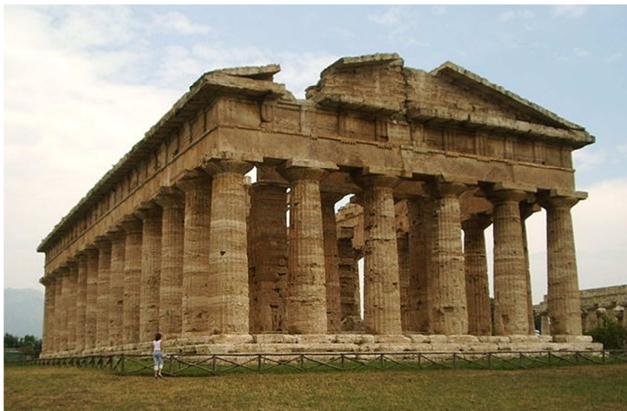
Figura 2.1.4: Tempio di Nettuno (Ispezione in sito).
