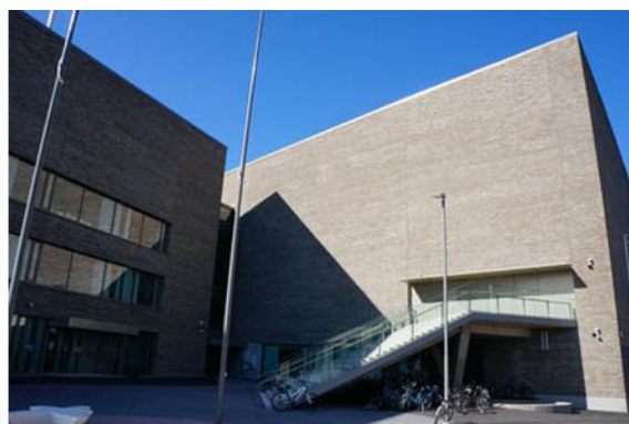
157 | Uno degli ingressi al complesso scolastico
