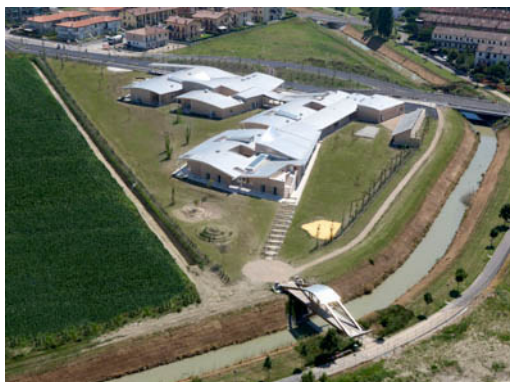
1 | Vista dall'alto dell'intero complesso
