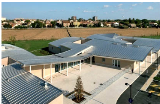
3 | La sinuosa copertura avvolge le parti della scuola
