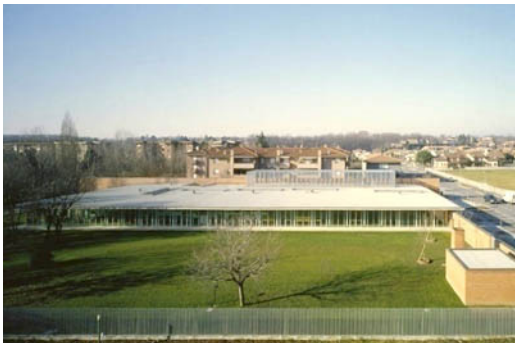
56 | Il cortile esterno su cui si affacciano le aule
