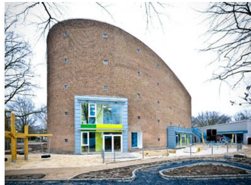
2 | Vista dell'edificio e del parco giochi esterno
