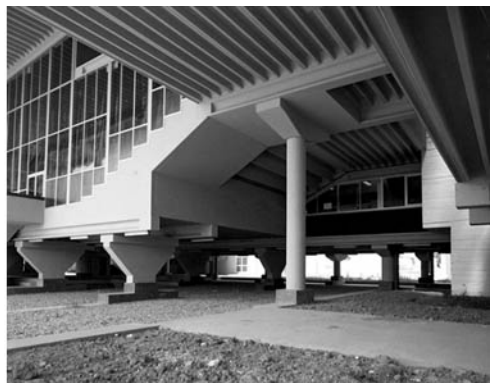
43 | Esterno: particolare delle strutture prefabbricate
