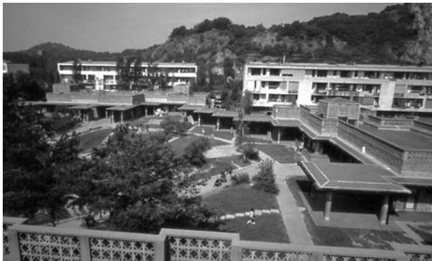
18 | Vista dell'intero complesso
