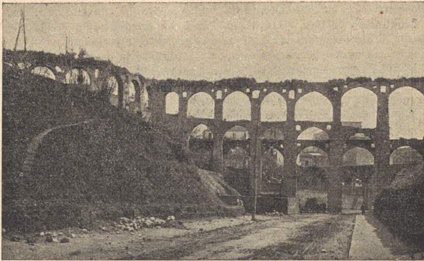
Gli acquedotti medioevali di Salerno.
