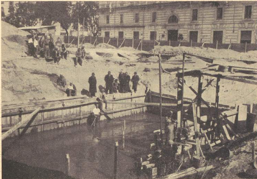
Salerno - Casa Littoria. Le fondazioni della Torre.
