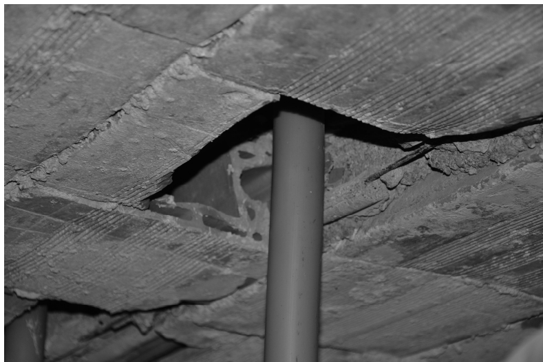
fig. 224: immagine di uno dei solai latero-cementizi del padiglione principale dell'ospedale.
