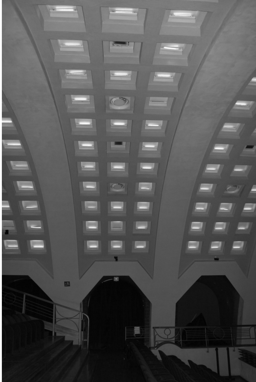
figg. 238: immagini dell'intradosso della volta dell'attuale cinema-teatro "Augusteo".
