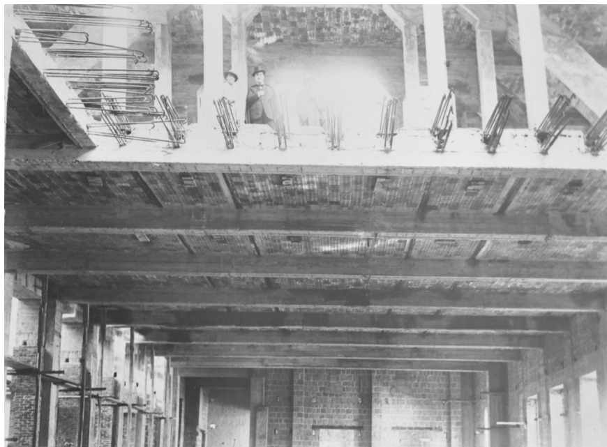
figg. 230 (immagini pp. 451 e 452): immagini di Palazzo di Città in costruzione dalle quali si evince la presenza di solai in latero-cemento. In particolare, dalla prima foto, si riscontra la presenza di solai del tipo Cannovale e Dellepiane , con laterizi a due fori e le tipiche alette laterali (da Archivio della Fondazione Guerra - facoltà di Ingegneria dell'Università di Napoli "Federico II").
