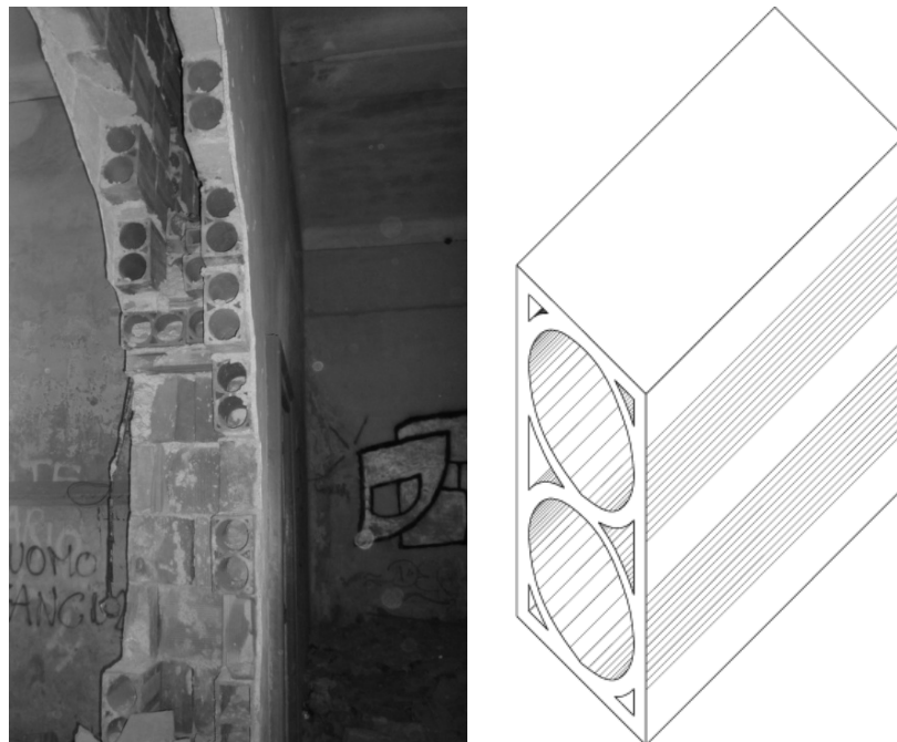
figg. 232: immagine di una parete realizzata con laterizi del tipo cannocchiale e assonometria 230 di un blocco. Si tratta di laterizi a due fori circolari, denominati “laterizi cannocchiale”, in riferimento proprio alla loro particolare forma che richiama il citato strumento ottico.
