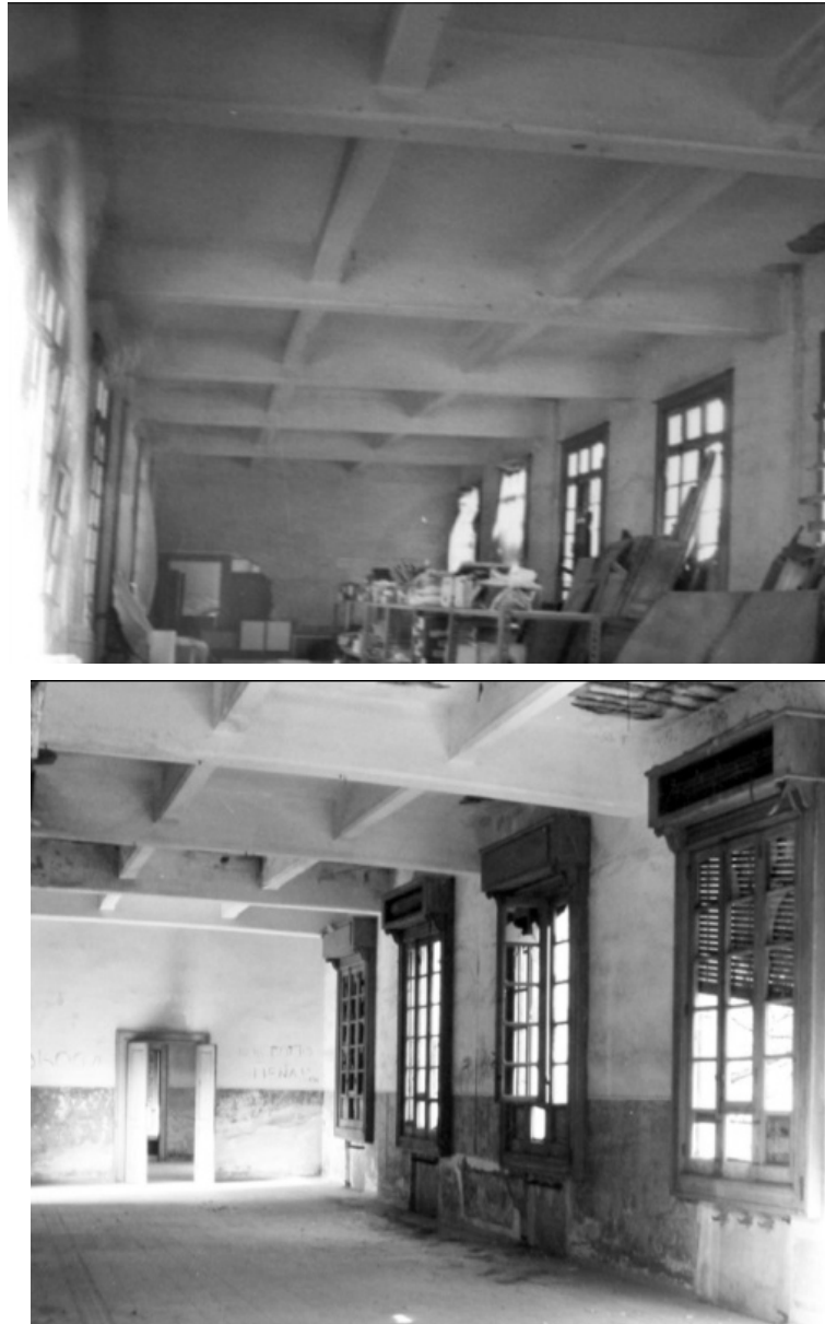
figg. 173: alcune immagini dei solai nervati dell'“Aerium” risalenti a prima dei lavori di recupero della struttura effettuati all'inizio degli anni Ottanta.
