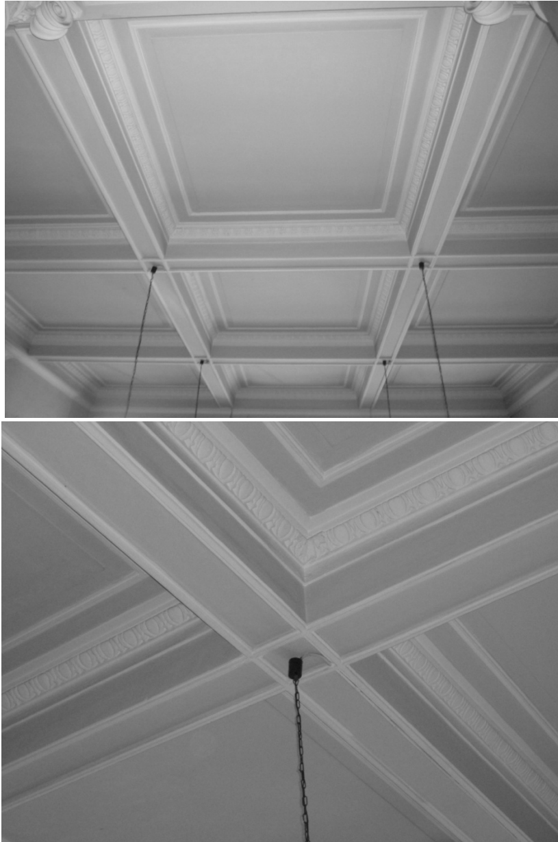
figg. 221: viste del solaio a cassettoni posto a copertura dell'atrio di ingresso principale e particolare di un nodo.
