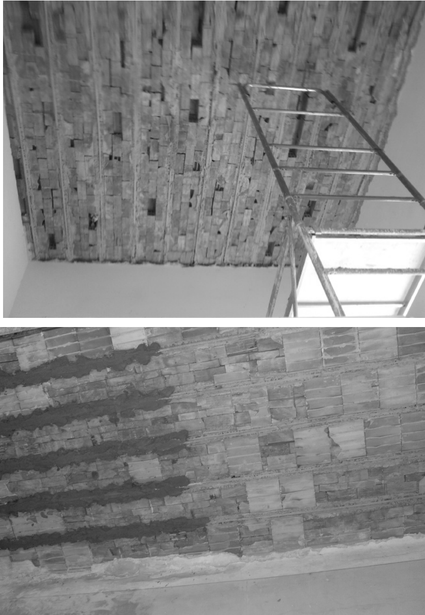
figg. 276: operazioni di trattamento delle armature metalliche con miscele a base di resine (in alto) e riparazione dei travetti (in basso).
