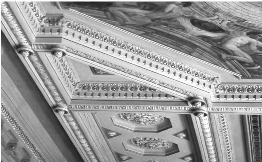
figg. 195: particolari del solaio a nervature della “Sala Genovesi”.
