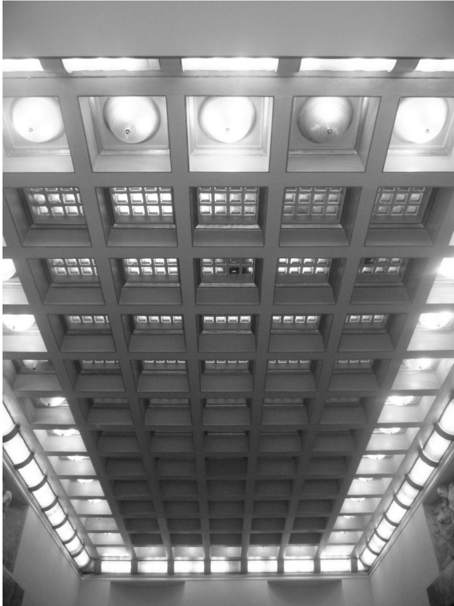
fig. 189: immagine del cassettonato di copertura della “Sala del Gonfalone”.
