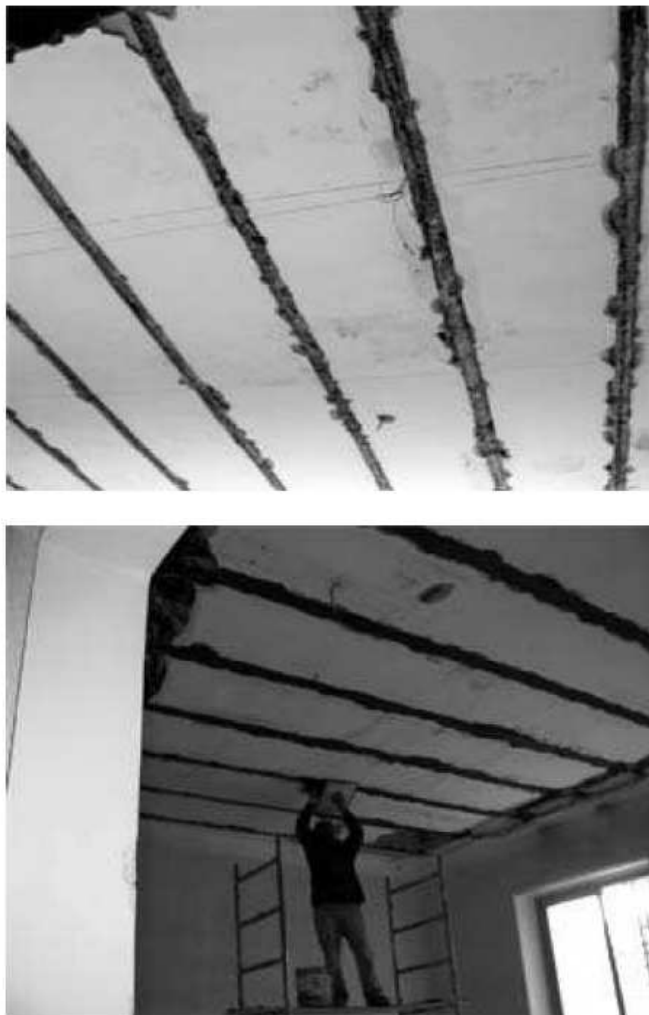
figg. 273: individuazione dei travetti in conglomerato cementizio armato mediante l'asportazione dell'intonaco (in alto) e ricostruzione della sezione degli stessi (in basso) (da Becco V., Recupero di un solaio in latero-cemento in "La gazzetta dei solai"- anno 5, n. 44, a cura della sezione solai dell'Audil Assolaterizi - Mensile di informazione tecnica sui solai in laterizio).
