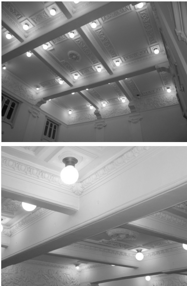
figg. 170: immagini del solaio in conglomerato cementizio armato a nervature incrociate posto a copertura del salone della Casa del Combattente.
