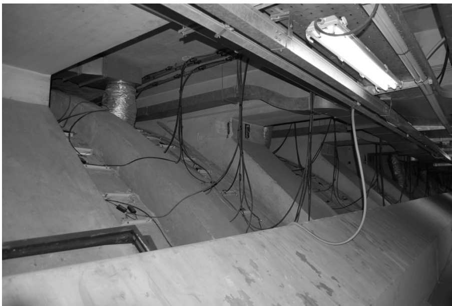
figg. 239: immagine dell'estradosso della volta in calcestruzzo armato, che ad oggi è adibito a locale tecnico.
