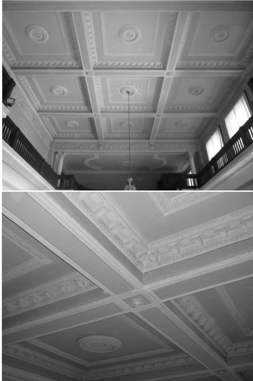
figg. 220: viste del solaio a cassettoni, riccamente decorato, posto a copertura dell'aula magna e particolare di un nodo.
