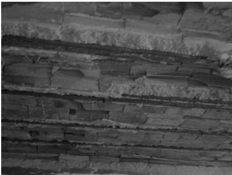
figg. 275: operazioni di puntellamento (in alto) e messa a nudo delle armature dei travetti (in basso).
