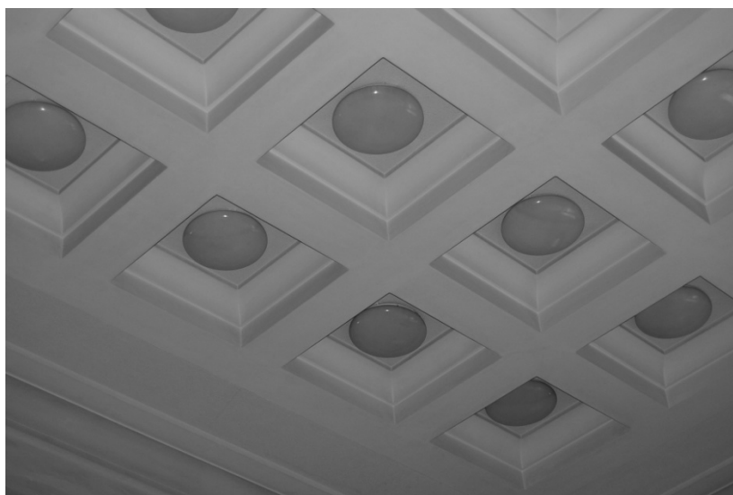
figg. 175 (immagini pp. 349, 350, 351 e 352): viste e dettagli di una delle porte d'ingresso alle varie sale del primo piano e dei solai a cassettoni posti a copertura, nell'ordine: dell'atrio prospiciente corso Vittorio Emanuele, dell'atrio al primo piano, lato corso Giuseppe Garibaldi e della sale d'udienza "Giucumbi" e "Parrilli", ubicate sempre al primo piano.
