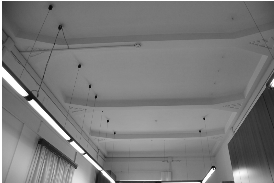
figg. 177 (immagini pp. 354 e 355): solai con travi emergenti ubicati in alcuni locali del secondo piano, nell'ordine: segreteria (in alto); ufficio amministrativo e stanza del G.I.P. (alla pagina successiva).
