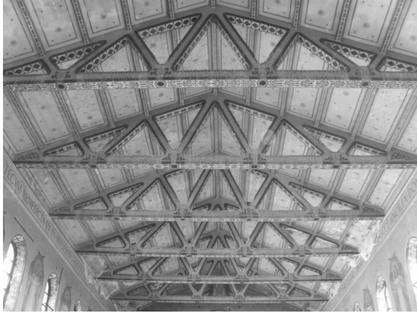
fig. 240: particolare delle capriate della Cappella Centrale del Seminario.
