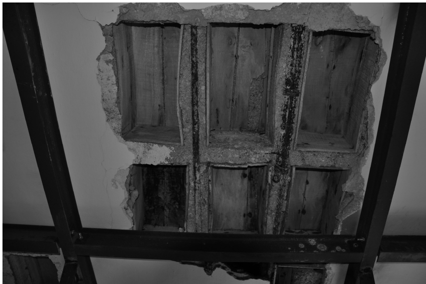
figg. 163: immagini del solaio Hulhanec e Leemann ad oggi ancora visibile in alcune zone controsoffittate dell'edificio.
