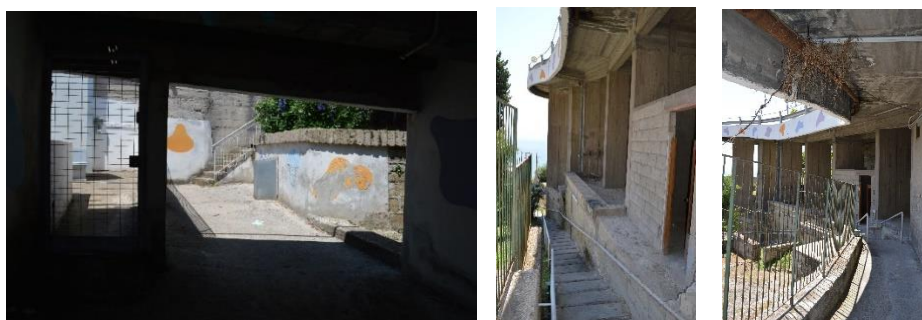
Fig. 3.52: Percorso pedonale di accesso.
