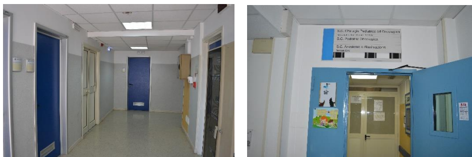
Fig. 3.57: Corridoi interni piano primo interrato e segnaletica.
