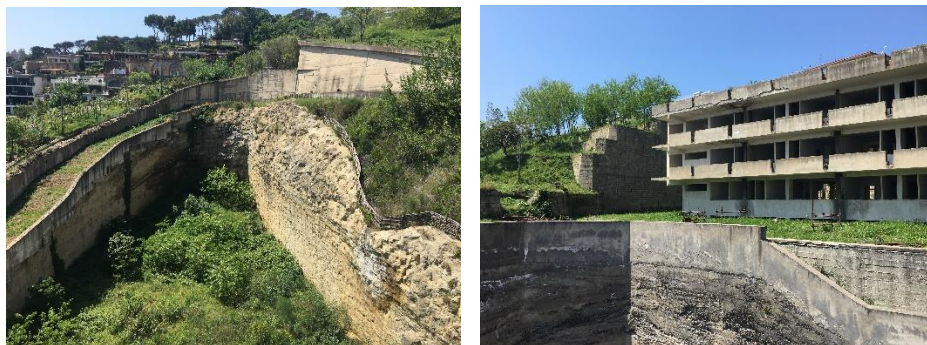
Fig. 3.62: Vecchio percorso esterno (a sinistra) ed edificio dismesso ex- Mercadante (a destra).
