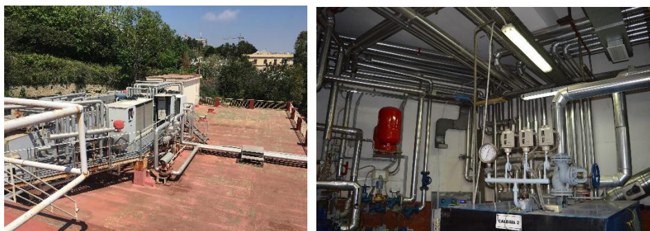
Fig. 3.63: Terrazzo e vano caldaia.
