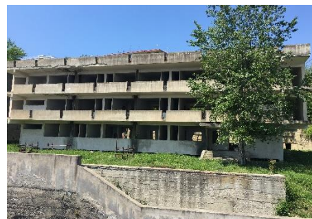
Fig. 3.49: Edificio Ex Mercadante.
