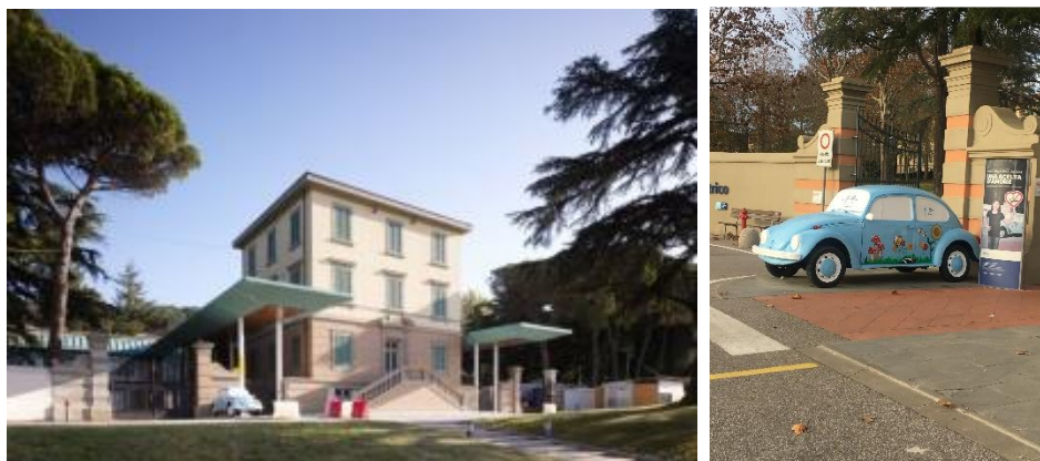
Fig. 3.7: Palazzina di ingresso.
