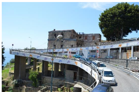
Fig. 3.48: Rampa di accesso.
