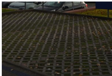
Fig. 3.38: Pavimentazione del parcheggio.
