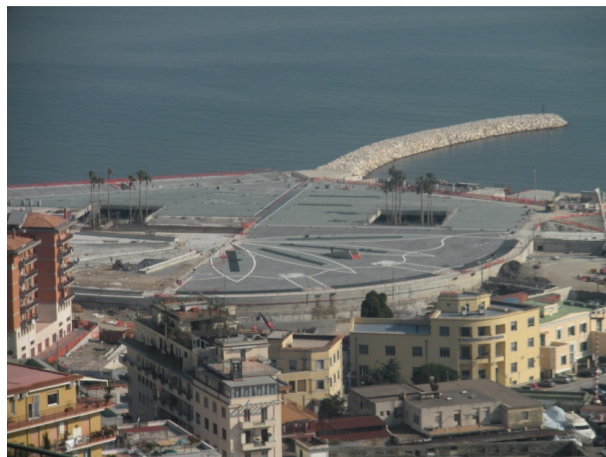
Fig. 47 Veduta del cantiere della piazza col parcheggio interrato, febbraio 2012
