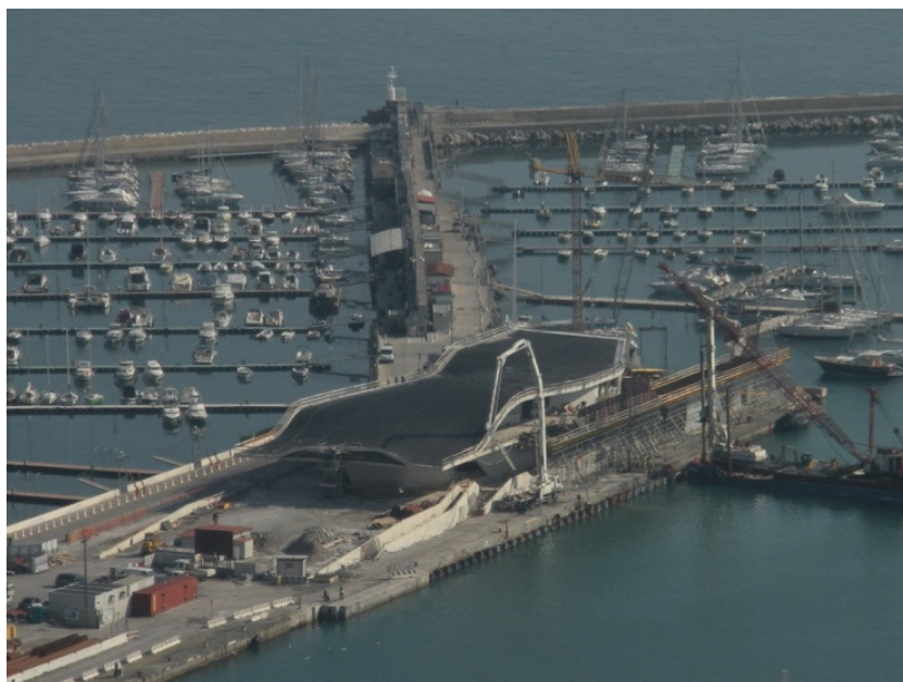
Fig. 50 Il cantiere della stazione marittima, stato dell'arte al febbraio 2012
