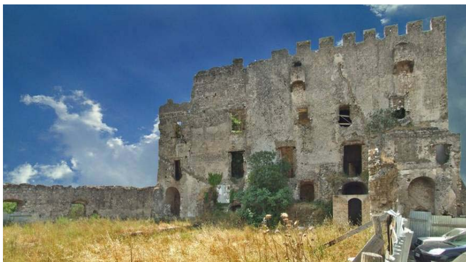
Fig. 79 Foto del prospetto prospiciente la corte
