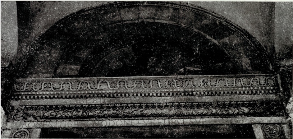
Fig. 2 - Salerno. Duomo. Architrave del portale centrale di facciata.
