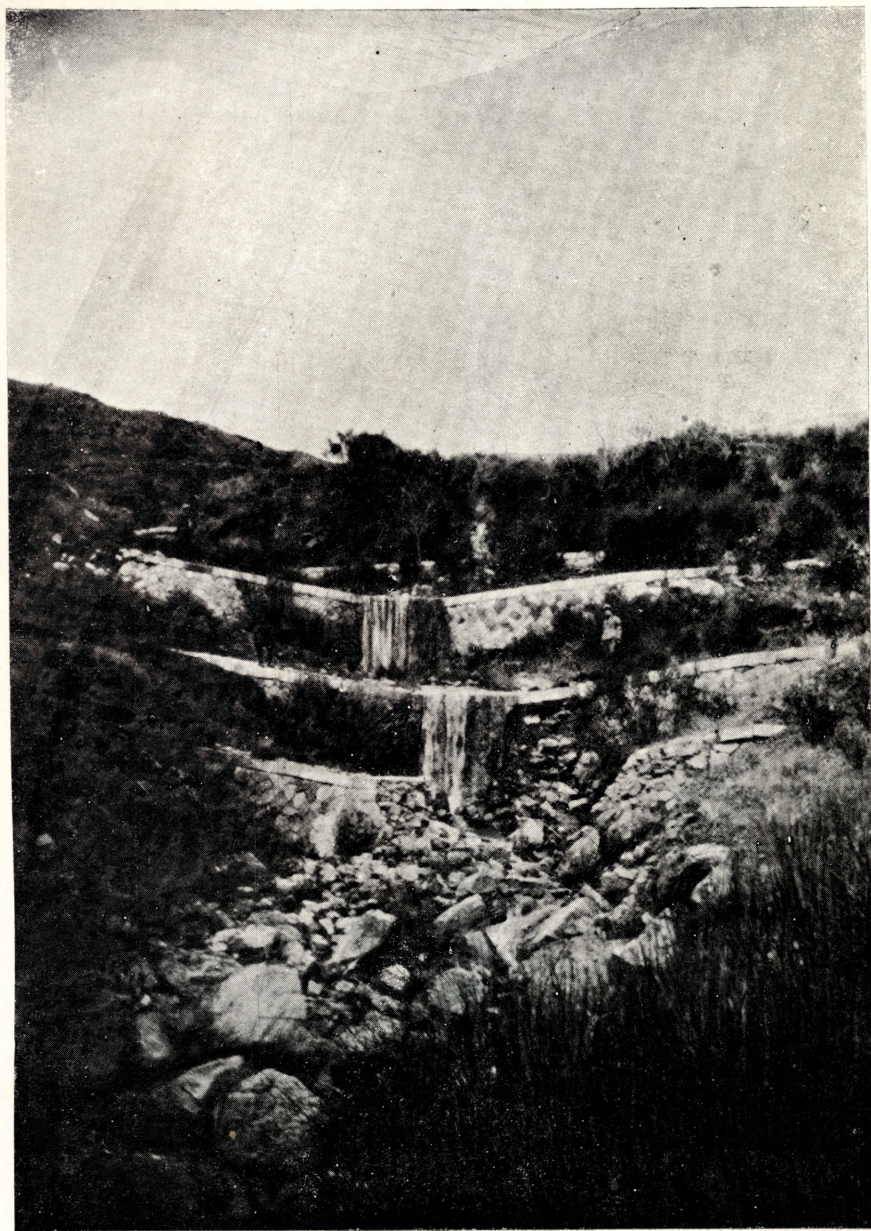
REAL CORPO DELLE FORESTE — Comando Gruppo Salerno TORRENTE PERTICELLA — Vecchie briglie in parte danneggiate (poi restaurate)
