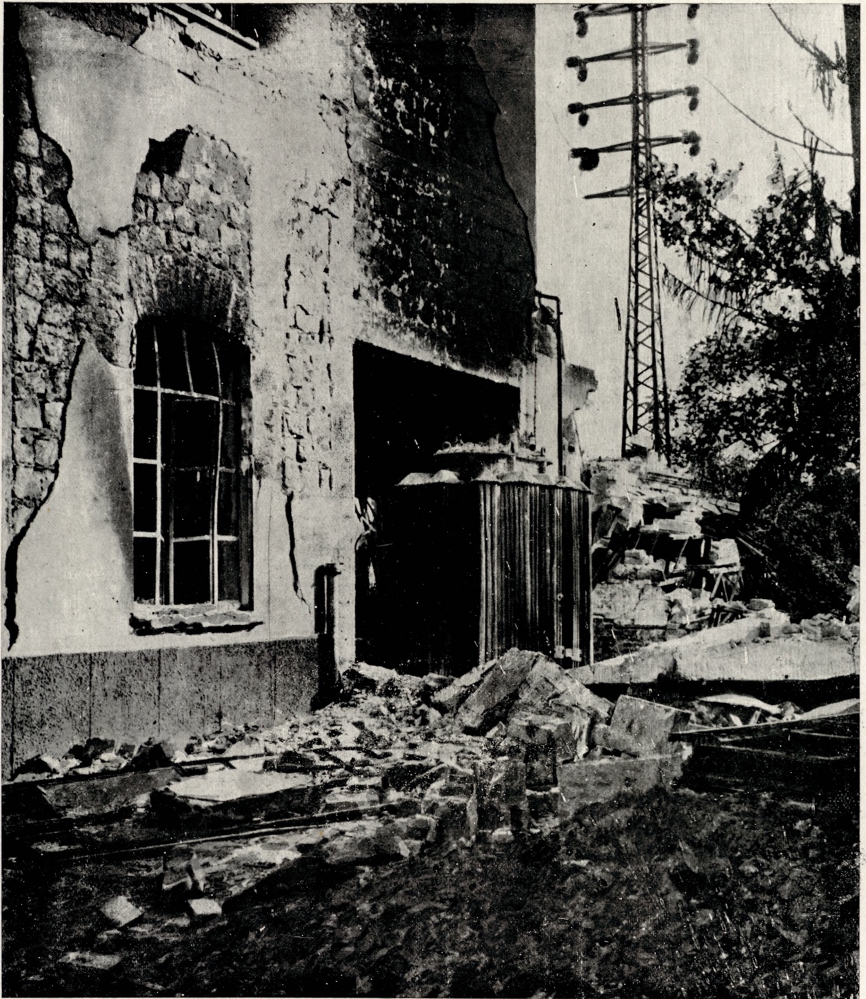
SEDAC - Via Orti - Salerno — SOTTOSTAZIONE A 30.000 VOLT
