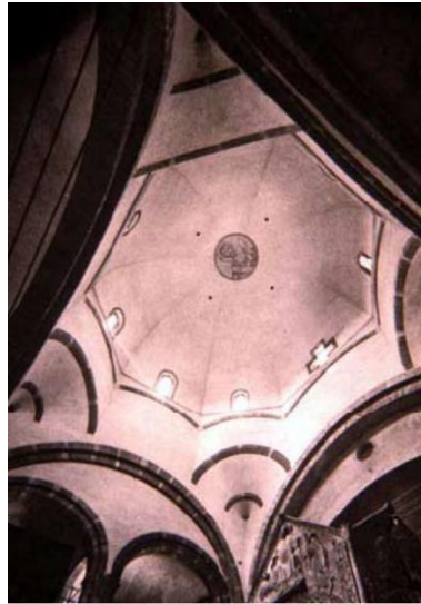
Figura 39: Milano, Basilica di Sant'Ambrogio, particolare della volta a padiglione all'intersezione tra il transetto e la navata centrale. (Chierici S., 1978)
