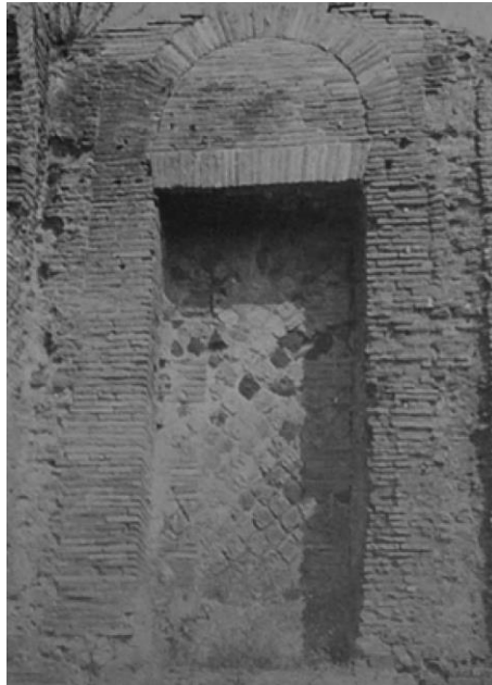
Figura 10: Piattabanda con arco di scarico, Larario di Pompei, 60 d.C. circa. (Adam J. P., 1998,188)
