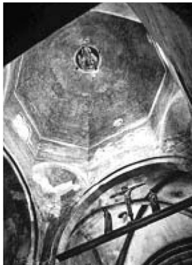
Figura 40: Pavia, Basilica di San Michele, particolare della volta a padiglione all'intersezione tra il transetto e la navata centrale. (Chierici S., 1978)
