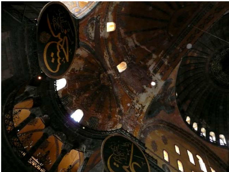
Figura 16: Particolare delle semicupole poste a contrasto della spinta della cupola centrale nella chiesa di Santa Sofia a Istanbul.
