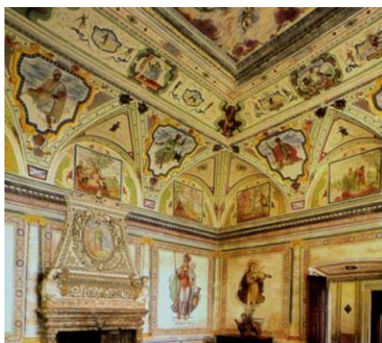
Figura 47: Palazzo Vertemate Franchi a Piuro di Chiavenna (XVI secolo); volta a specchio lunettata (detta anche a peducci) della sala di Giove e Mercurio.
