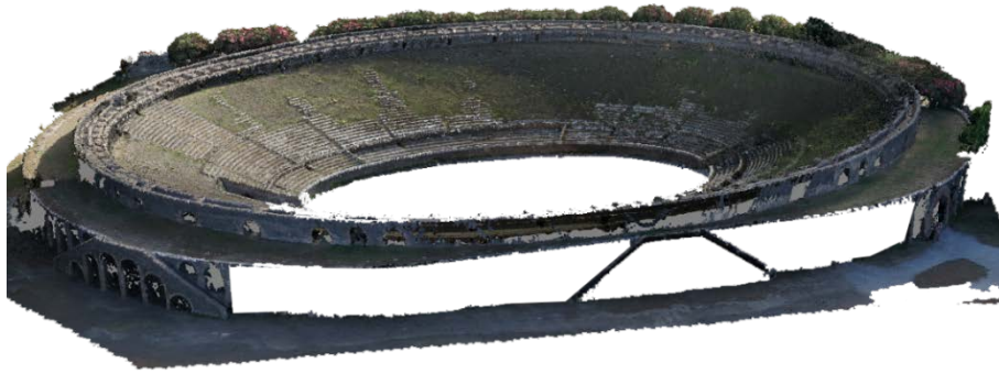
Figura 52: Vista de la nube de puntos producida con aerofotogrametría.
