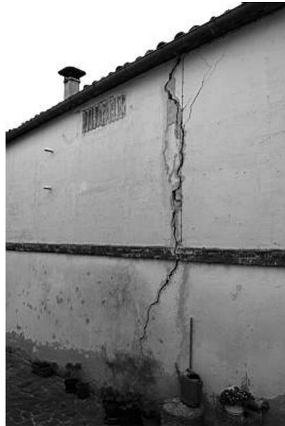
Figura 1.2: Fessurazione dovuta a trazione pura
