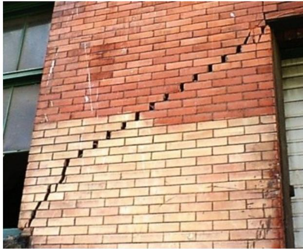
Figura 1.3: Fessurazione dovuta a compressione e taglio
