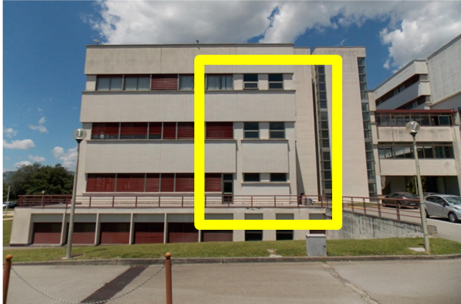
Fig. 2.7: Prospetto Sud-Est dell'edificio.
