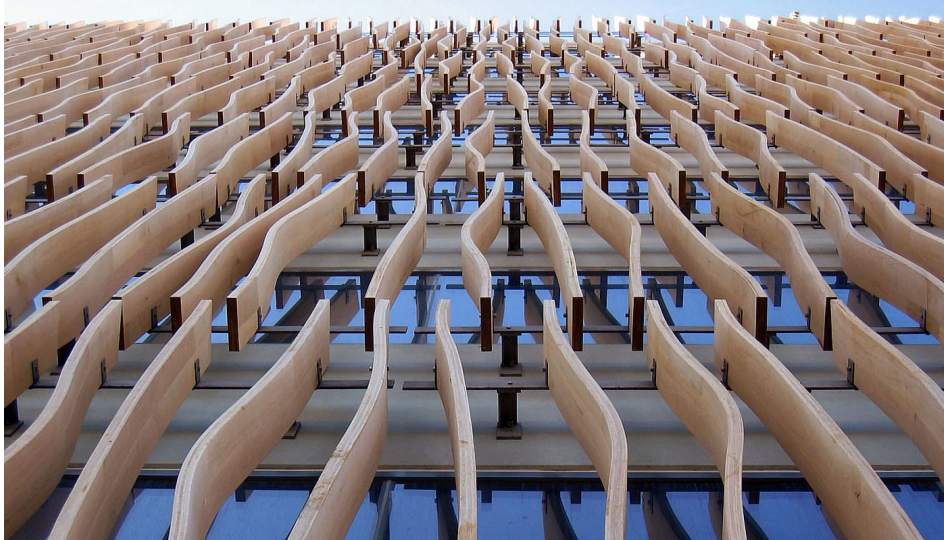
Fig. 1.18: Dettaglio brise-soleil di facciata.
