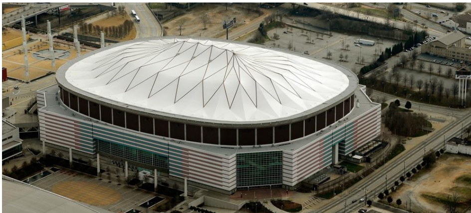
Fig. 1.49: David H. Geiger, Georgia Dome , Atlanta, Georgia, 1992
