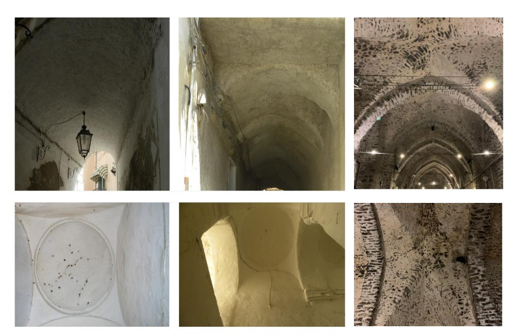
TAV. 21 Esempi di edifici con impalcati a volta a Minori. Volte a crociera negli Arsenali di Amalfi (a destra).
