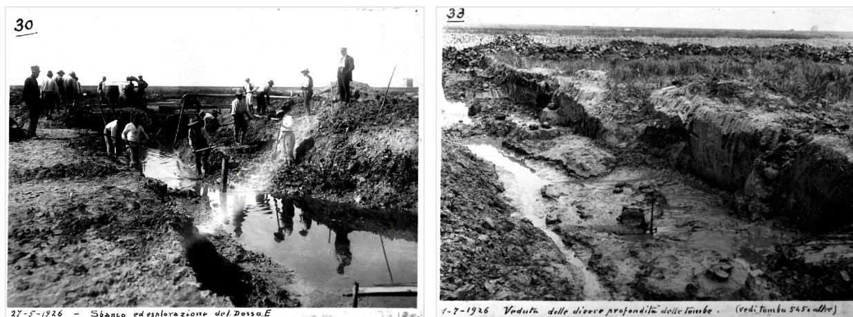
Figg.4. 5-5: Operazioni di scavo nel Campo 52: a destra, il Dosso I, a sinistra, il Dosso E.
