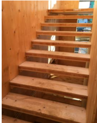
FIG. 37 SCALA REALIZZATA MEDIANTE PEDATE IN PANNELLI X-LAM COLLEGATI ALLE PARETI PERIMETRALI MEDIANTE ANGOLARI METALLICI AVVITATI
