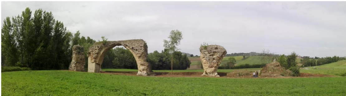
Fig. 80 – Ponte Rotto sul Calore.
