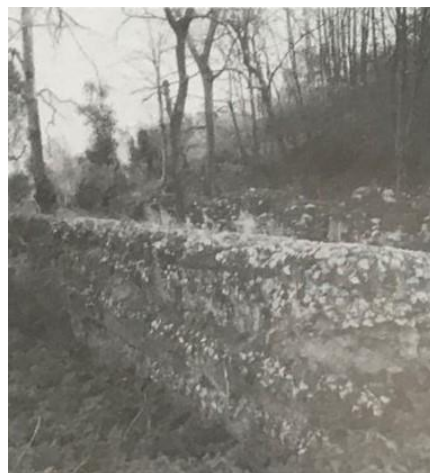
Dettaglio delle fondazioni a vista ( ATTA 3 , fig. 110)
