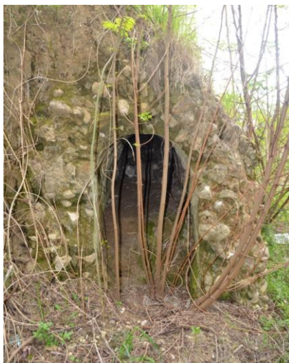
Tratto di acquedotto presso via Avellino
