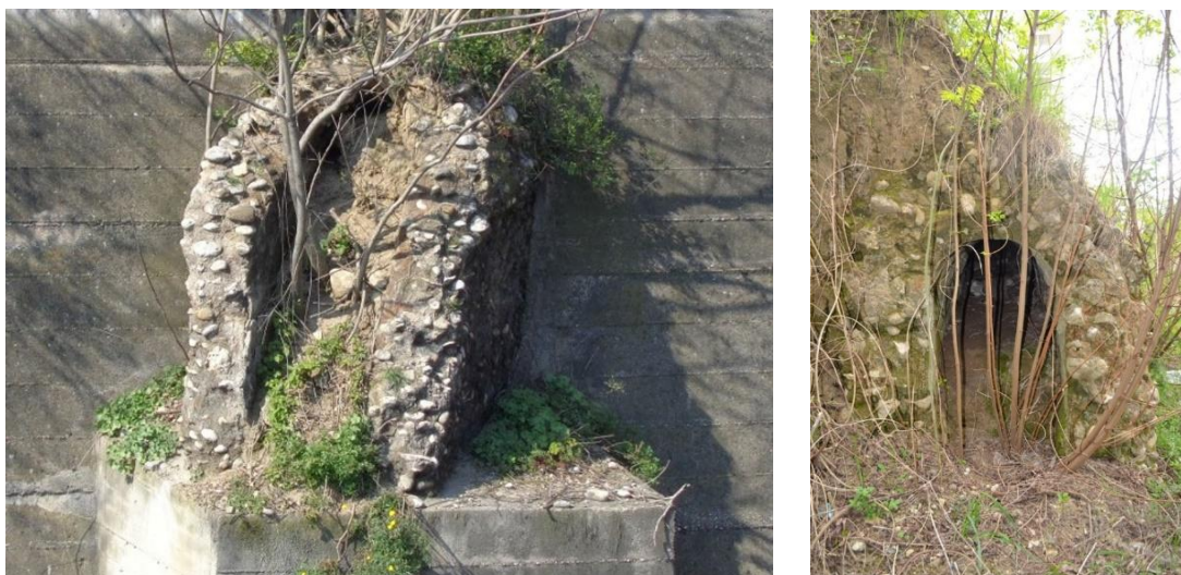
Fig. 82 – A sinistra: tratto di via Avellola; a destra: tratto di via Avellino.
