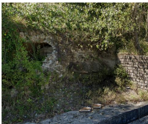
Tratto di Acquedotto presso Airola
