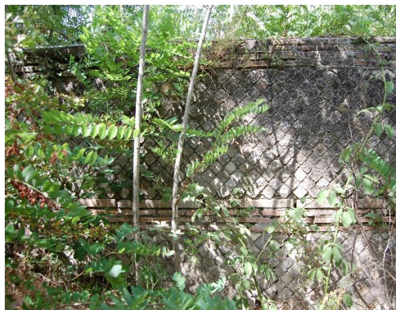
Rampa di accesso al ponte
