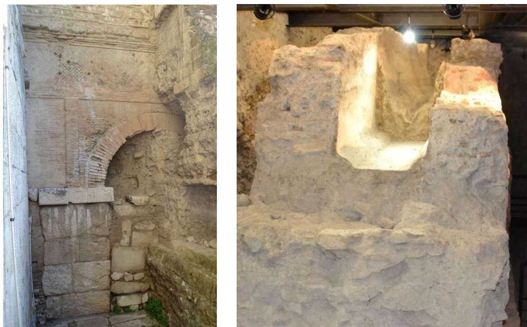
Fig. 83 – A sinistra: Arco presso la Rocca dei Rettori sormontato dallo speco dell'acquedotto con paramento esterno in opera reticolata; a destra: speco all'interno degli ambienti della Rocca dei Rettori.
