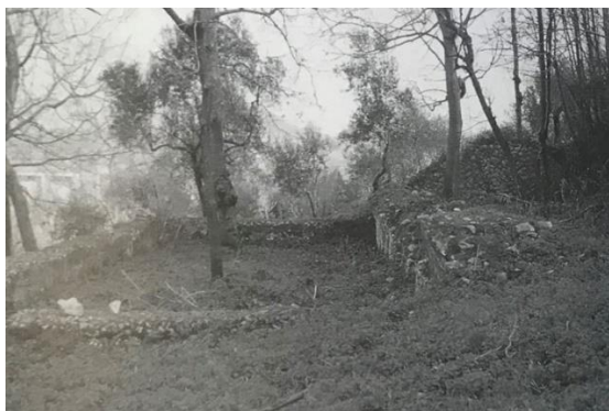
Particolare delle cisterne ( ATTA 3 , fig. 109)
