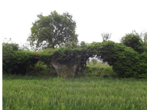
Il Ponte Serretelle oggi
