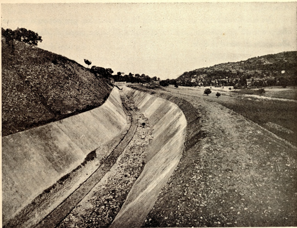
I lavori per la costruzione del canale principale d'irrigazione
