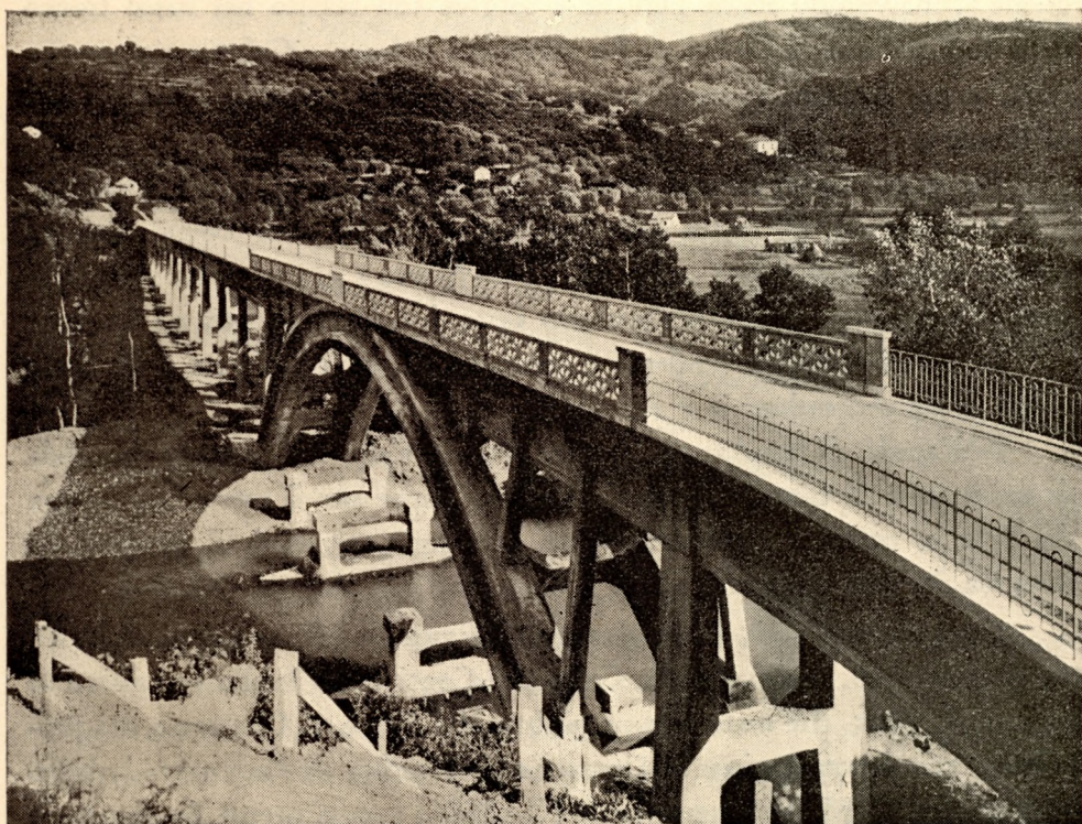
Ponte canale e stradale sul fiume Calore
