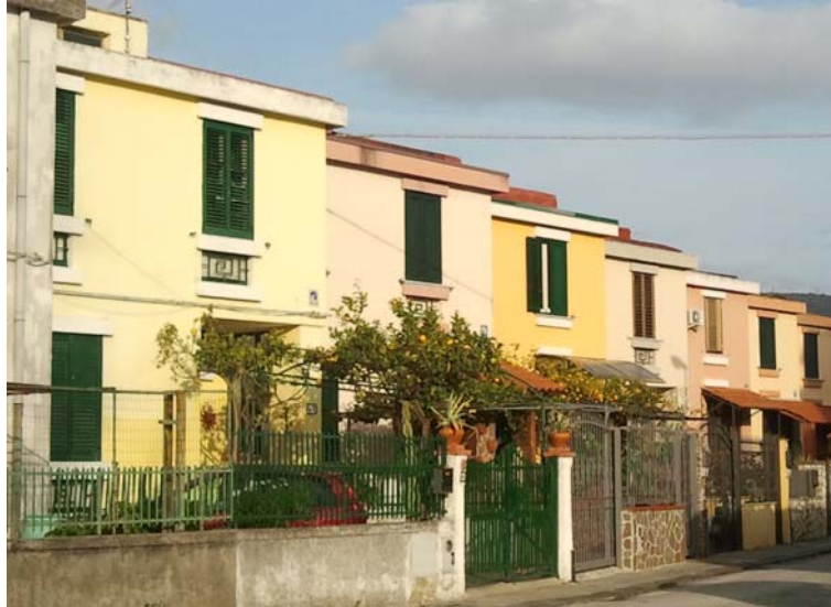
Fig.4. 3: Building C duplex Quartiere Pastena, INA-Casa, Bruno Zevi - Salerno.
