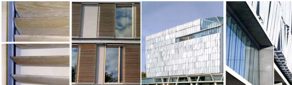
Fig. 2. 12: Two examples of external shading devices: wood blinds and shade rolls. – from S. F.Brivio “Schermature solari e tende tecniche - Metodi e soluzioni di progetto, tipologie, risparmio energetico” Il Sole 24 Ore, 2010.
