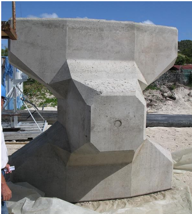
Figura 2.14 Un Accropodo pronto per la posa in opera
