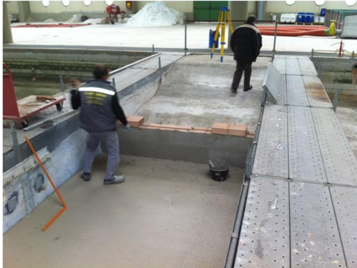
Figura 4.23 Realizzazione del muro di contenimento
