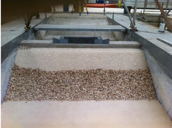
Figura 4.25 Realizzazione dello strato filtro
