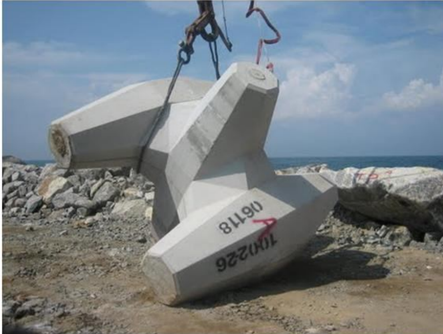
Figura 2.16 Un Core-loc pronto per la posa in opera
