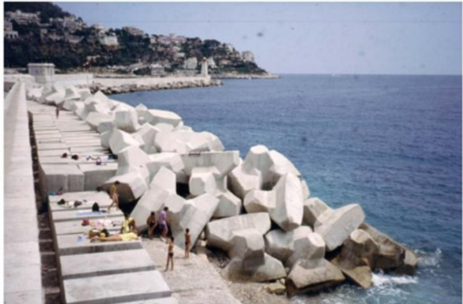
Figura 2.15 Diga a scogliera realizzata con Accropodi - Nizza
