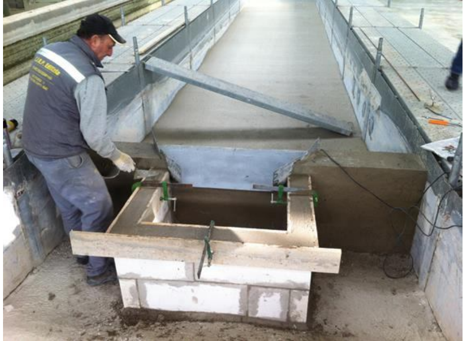
Figura 4.45 Sistema per la misura dei volumi di overtopping. E' visibile lo scivolo metallico per convogliare le acque di sormonto in una vasca (non presente in foto) alloggiata in un'altra vasca in muratura, stagna, in fase di costruzione
