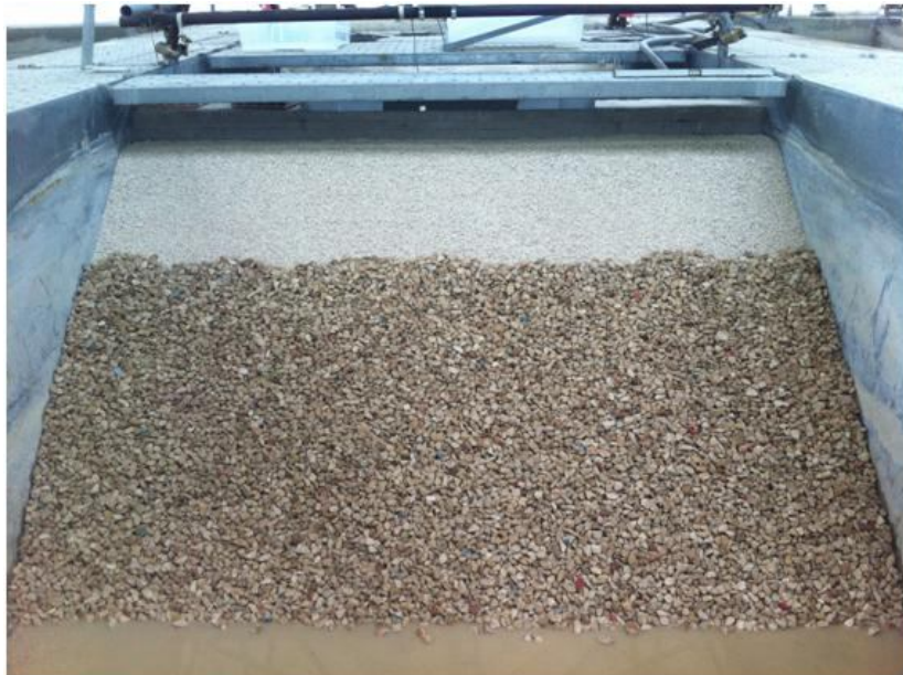
Figura 4.29 Lavori per la realizzazione della nuova barriera: lo strato filtro
