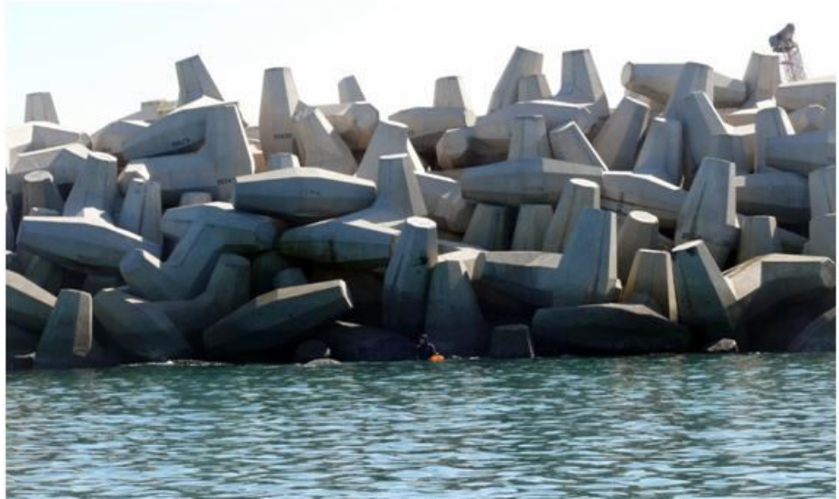
Figura 2.13 Diga a scogliera realizzata con Dolos
