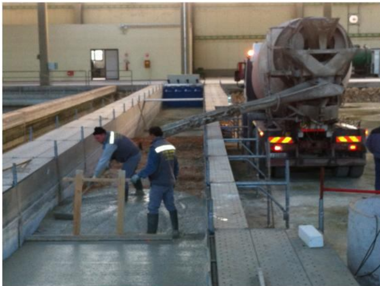
Figura 4.20 Realizzazione della sopraelevazione del fondo
