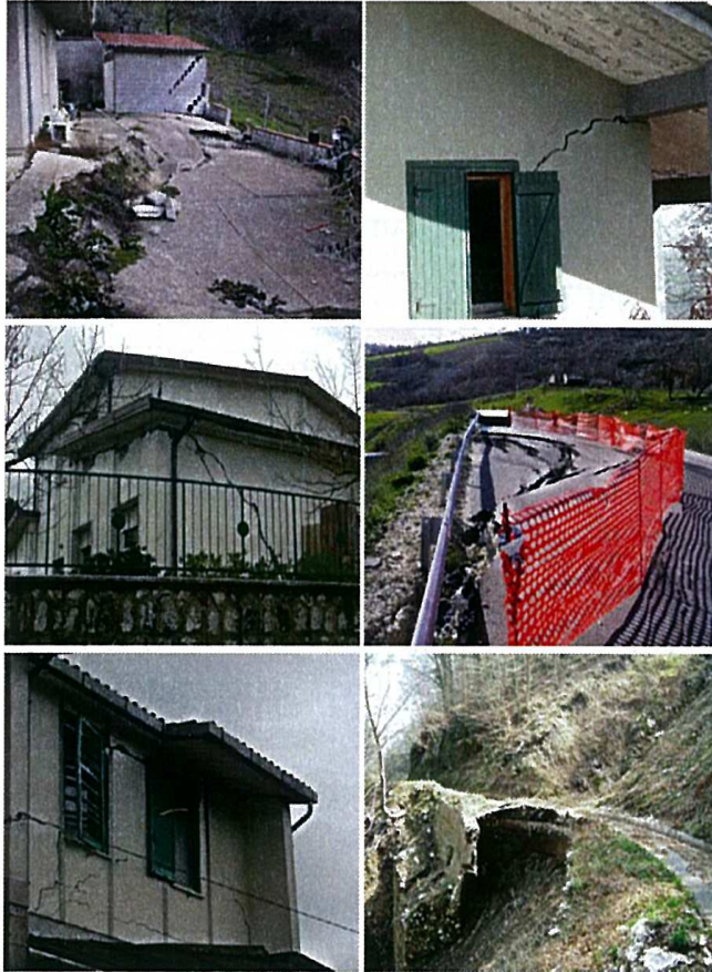
Figura 5.2. Esempi di danni a costruzioni interagenti con corpi di frane a cinematica lenta nel territorio dell'ABN LGV.
