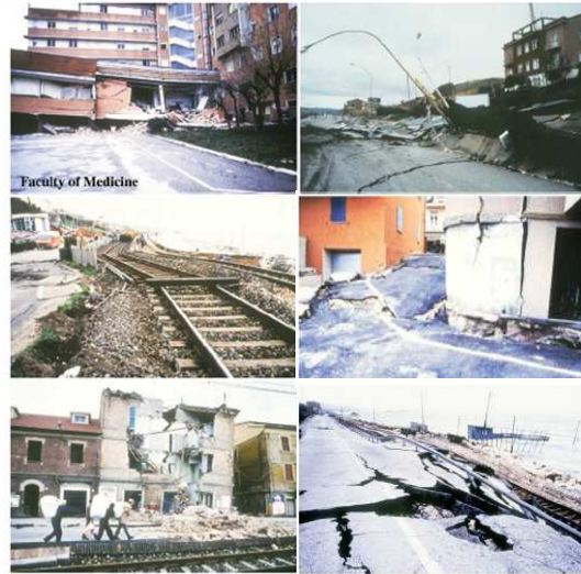
Fig. 2.21. Frana di Ancona: effetti indotti sul costruito (Cotecchia, 2006).
