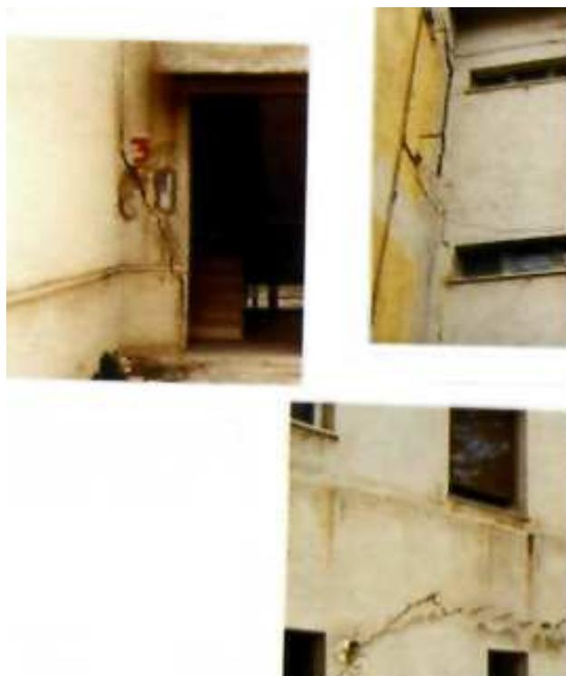
**Figura 6.29. Quadro fessurativo delle Case popolari (Gullà, 2003).**
