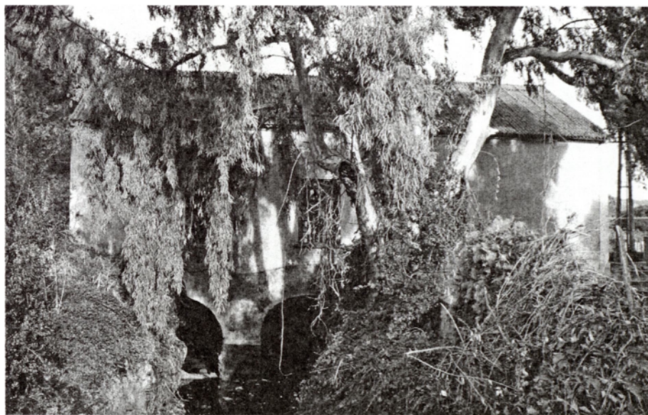
L'ex centrale idroelettrica Maida – I cunicoli di scarico
