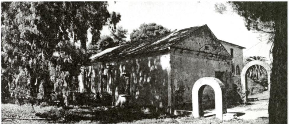
L'edificio della sala macchine e in secondo piano l'abitazione del custode
