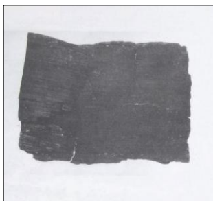
Fig. 2. Pezzo di trave della copertura
