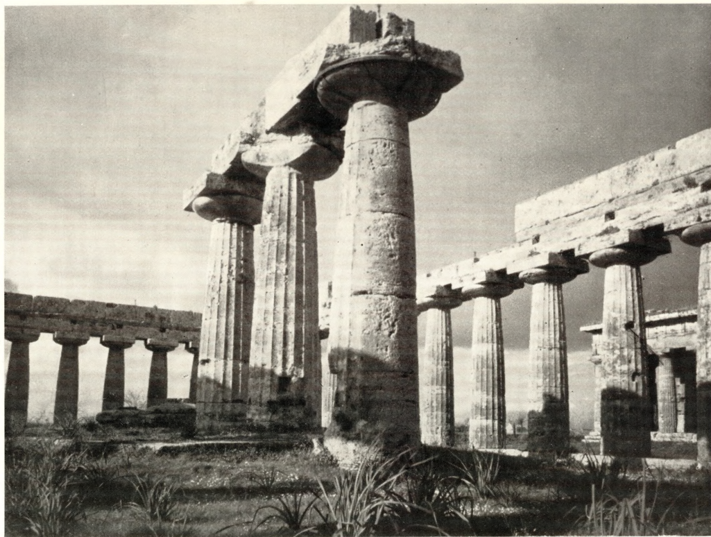
Paestum. - La così detta Basilica , la cui grandezza era superata di poco dal Partenone, elevandosi su un porticato esterno di ben 50 colonne.
