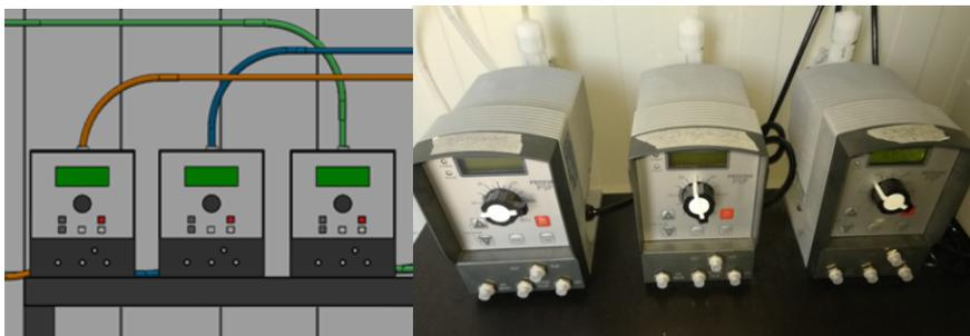
**Figura 5.30** Pompe dosatrici progettazione (a sinistra) e vista reale (a destra)
