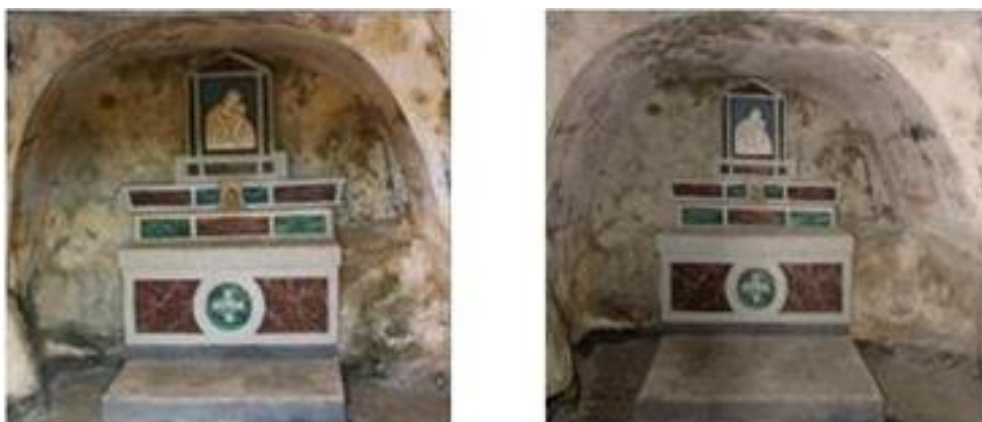
Figura 80. Particolare della chiesa Madonna dei Derelitti prima e dopo il trattamento di pulizia
