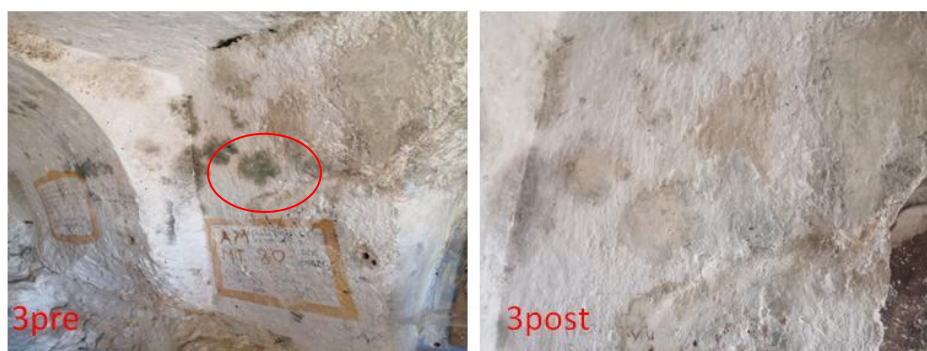
Figura 89. Area di prelievo campione #3 pre e post trattamento
