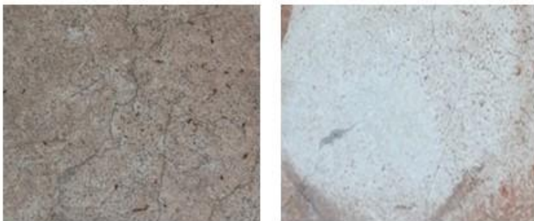
Figura 144. Risultato della rimozione della macchia di ferro
