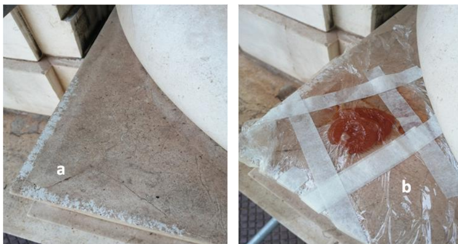
Figura 143. (a) Piedistallo della colonna: area di intervento; (b) gel dopo 20 ore di applicazione
