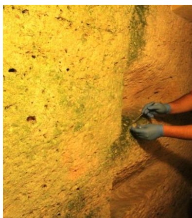
Figura 56 . Campionamento preliminare nell'area orizzontale della parete di studio
