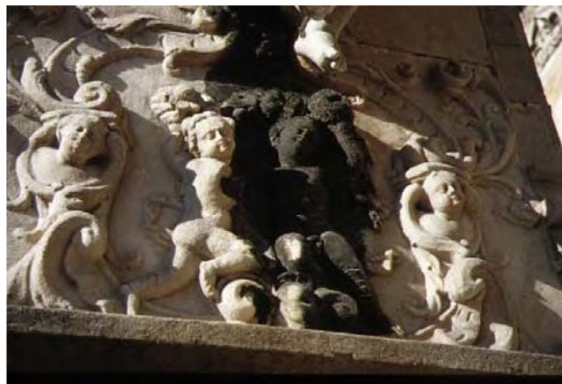
Figura 2. Esempio di formazione di croste nere
