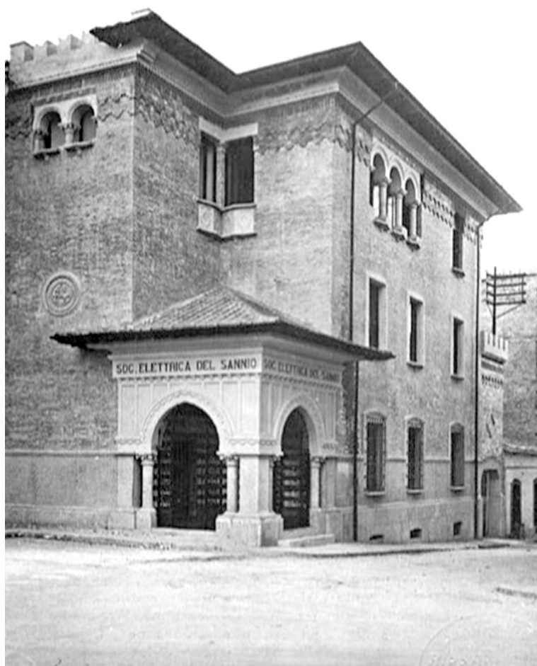
Fig. 11 - Il Palazzo della Società Elettrica del Sannio realizzato a Campobasso negli anni venti del Novecento (Campobasso, Archivio Palladino).
