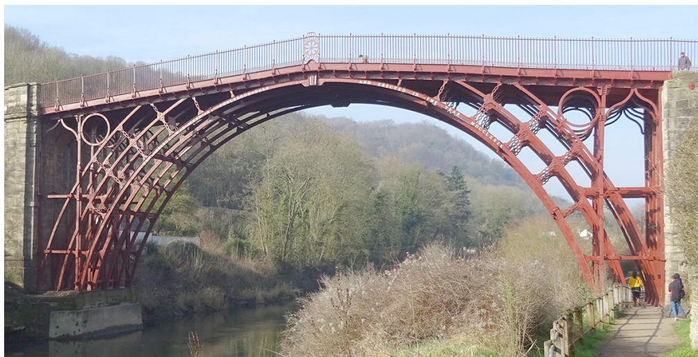
Fig. 1 - Fonderia di Abraham Darby, Iron Bridge, 1777 - 1781, Coalbrookdale
