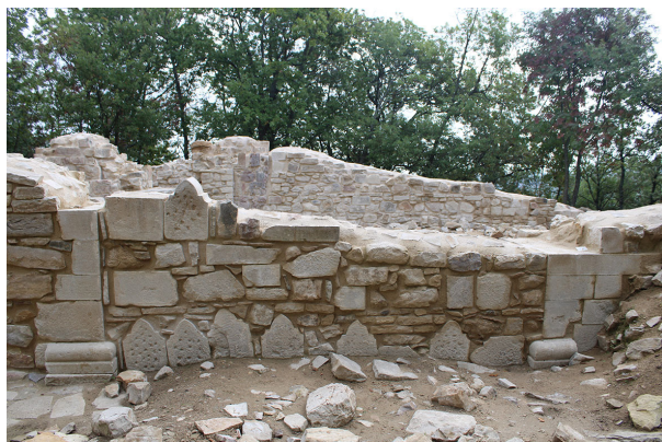
Fig. 8 - Sant'Elia a Pianisi, chiesa di S. Maria a Pianisi. Conci modanati con profilo ogivale reimpiegati nella tamponatura di una delle arcate di collegamento tra le navate (foto Vincenzo Castaldo).
